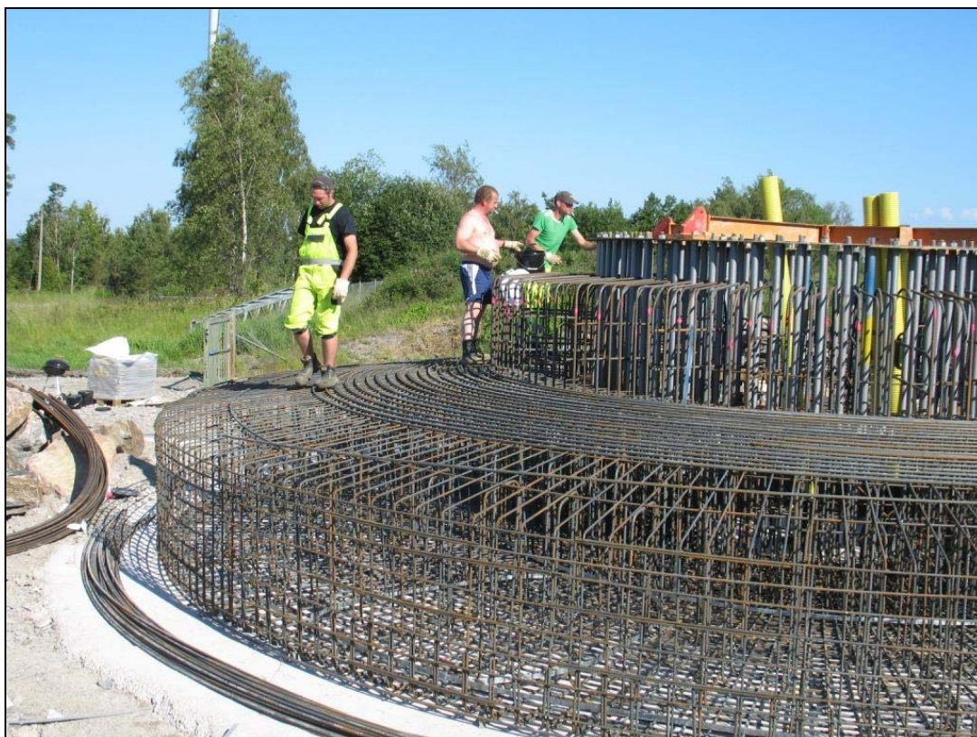
Armering av fundament till ett 0,9 MW vindkraftverk. (Foto B Ahlqvist)
