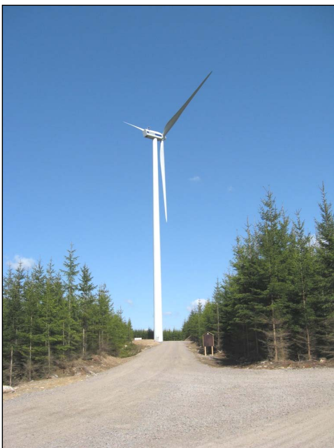
Vindkraftverk med ett 100 m torn och 90 m vingdiameter. (Foto B Ahlqvist)
