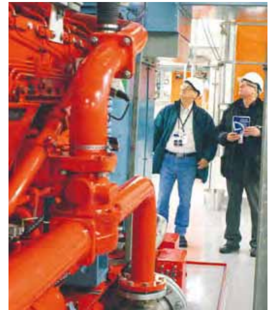
Dieselutrymmet i Forsmark granskas av Neil Henderson, OSART, här i sällskap med Olof Hellström, Forsmarks Kraftgrupp.
