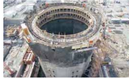
Forsmark 3 under uppförande i oktober 1982. Forsmark 1 och 2 är då redan driftsatta.
