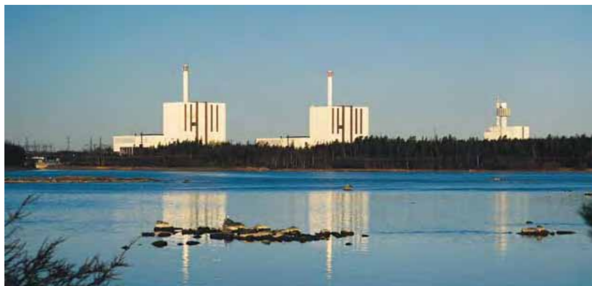
Många som bor i närheten av Forsmark har stort förtroende för verksamheten på kärnkraftverket. Foto: Hans Blomberg.
