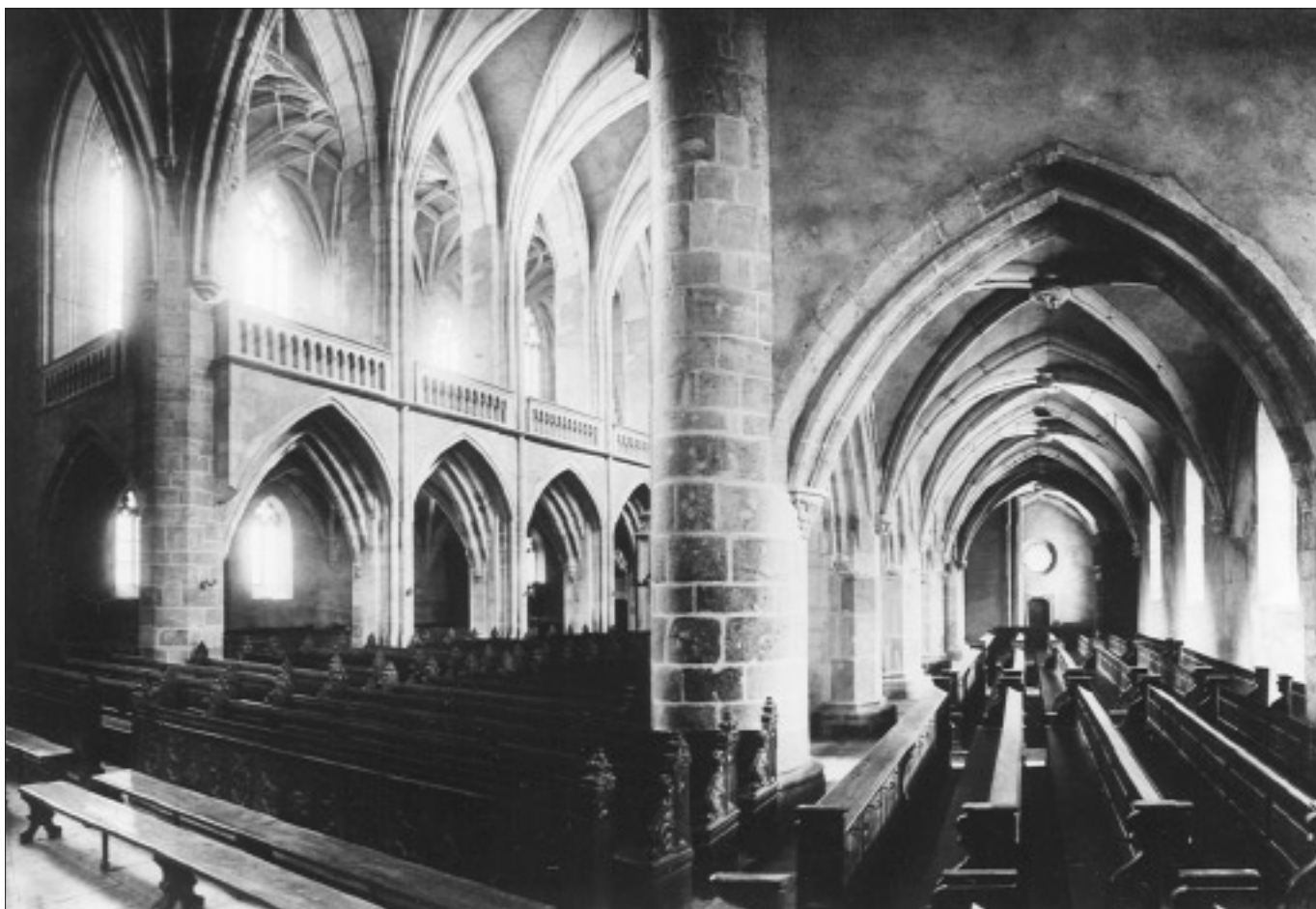
28. Vedere parțială a navei centrale și a navei laterale nordice. Fotografie din anii '30.
