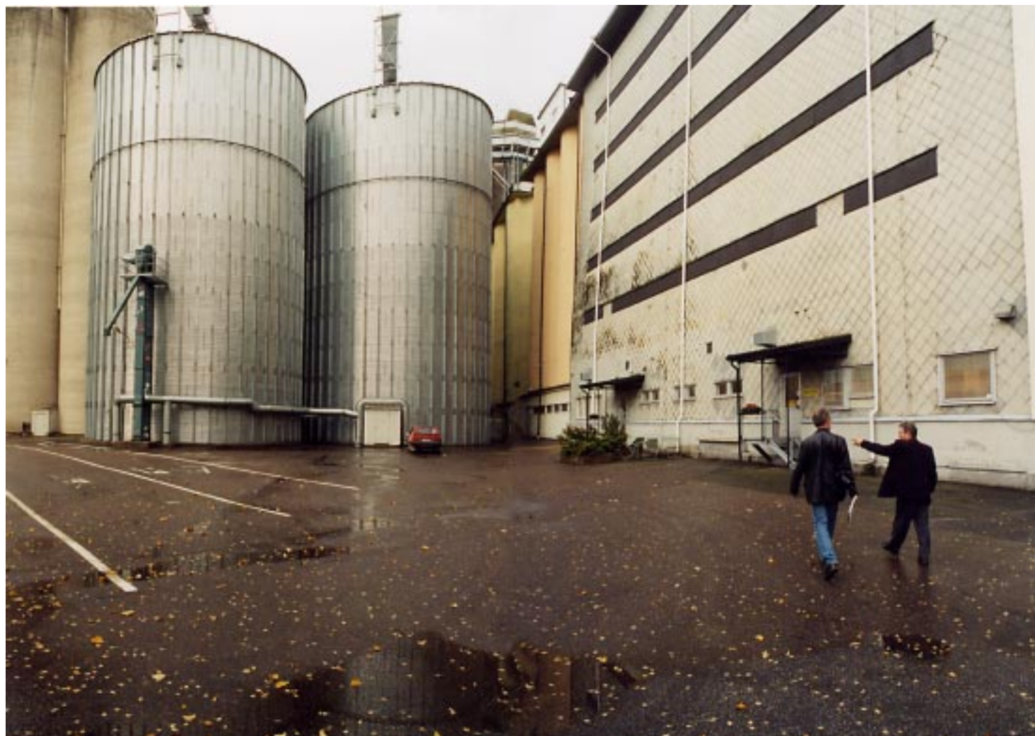
År 1997 byggdes de första silotornen av plåt på gården som bildats mellan 1939 och 1985 års betongsilor. Till vänster i marken ses de olika filerna för leveranser av olika sädesslag. Foto i okt. 2004, TCq, montage.
