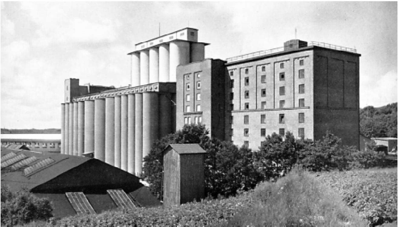
Spannmålssilo och magasin på Kvarn AB Tre Lejon, Göteborg. Kvarnen byggdes 1914 av AB Märten Pehrsons Valsqvarn och inköptes 1925 av KF:s dotterbolag Tre Lejon. De sista 10 åren före nedläggningen 2001 var den känd som Juvelkvarnen. Silotornen på bilden byggdes mellan 1916 och 1935, de äldsta var bland de första som byggdes av armerad betong i Sverige. Enligt detaljplan från 2004 skall alla cylindriska silor ersättas av bostadshus. Rivningen påbörjades våren 2006. Efter foto i Armerad Betong 1916-1946.
