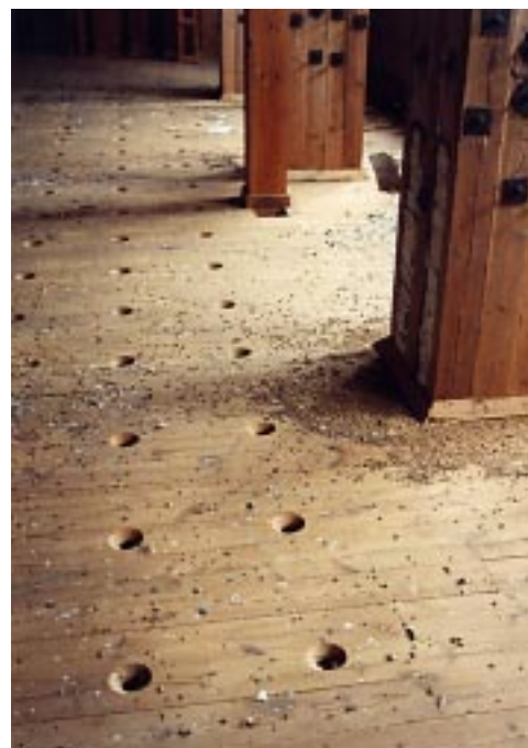
Genom hålen i golven silar säden till närmast underliggande plan. Eslöv. Foto i juli 2004, TCq.
