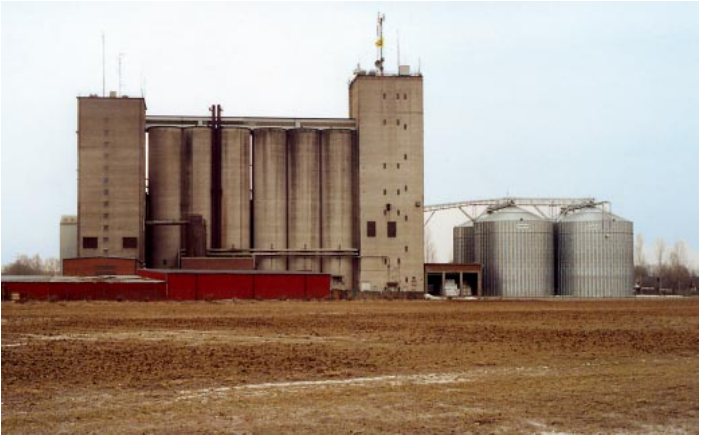
Anläggningen sedd från NV 2005. Från vänster ses torktornet från 1955, betongsilor från 1969 och 1975, det 55 m höga maskintornet från 1975 och till höger 2003 års plåtsilor. Foto i mars 2005, TCq.
