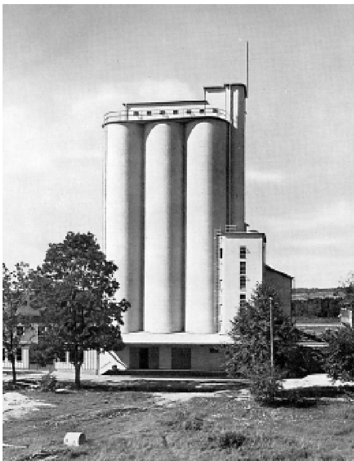
Centralföreningens första betongsilo i Falköping byggdes 1944. Funktionalismens ideal passade till dessa nya arkitektuppgifter. Efter foto i Armerad Betong 1916-1946.
