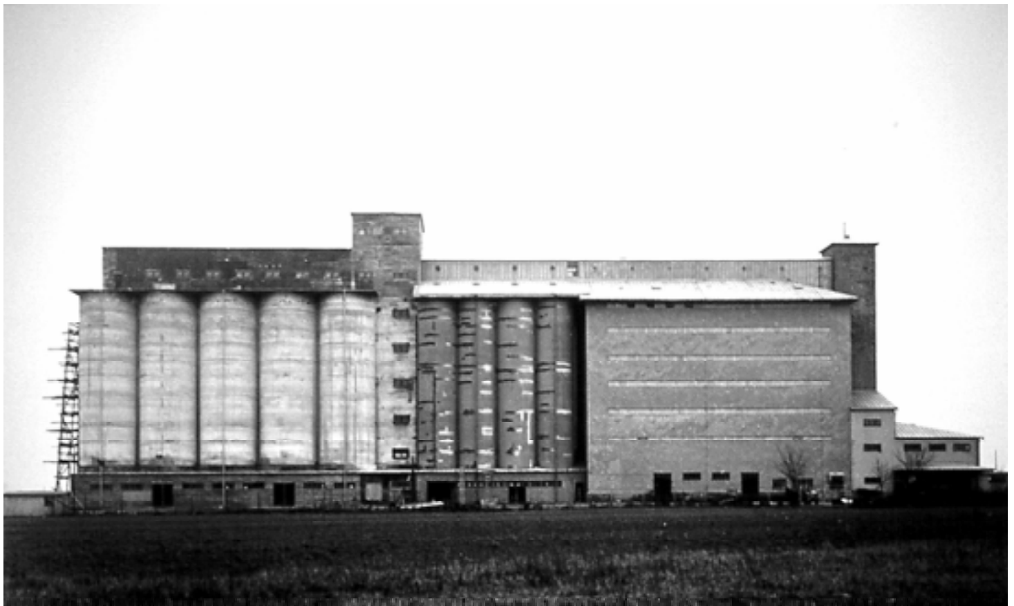
Anläggningen från sydväst, troligen 1939 just innan byggnadsställningarna hade tagits ned efter den andra utbyggnadsetappen. Bättringsarbeten pågår på 1934 års silor. Foto JA Kock i VGM.
