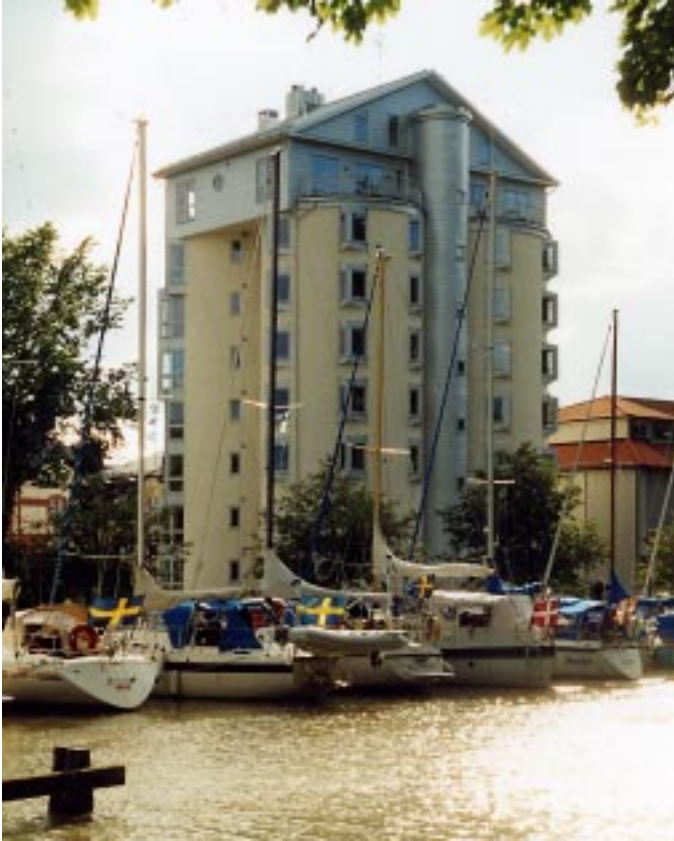
Söderköping. Silo från 1944 ombyggd till bostäder med sjöutsikt. Foto i juli 2005, TCq.
