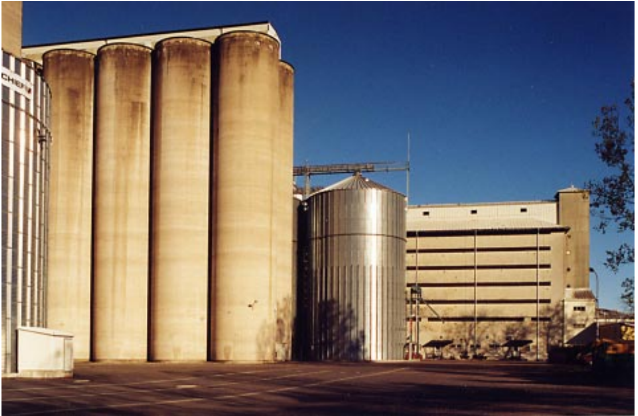
Betongsilos från 1985, plåtsilos från 1997 och till höger det gamla lagerhuset av trä från 1918 bildar tillsammans en intressant utvecklingsserie av byggnader för spannmålslagring. Foto i okt. 2004, TCq.
