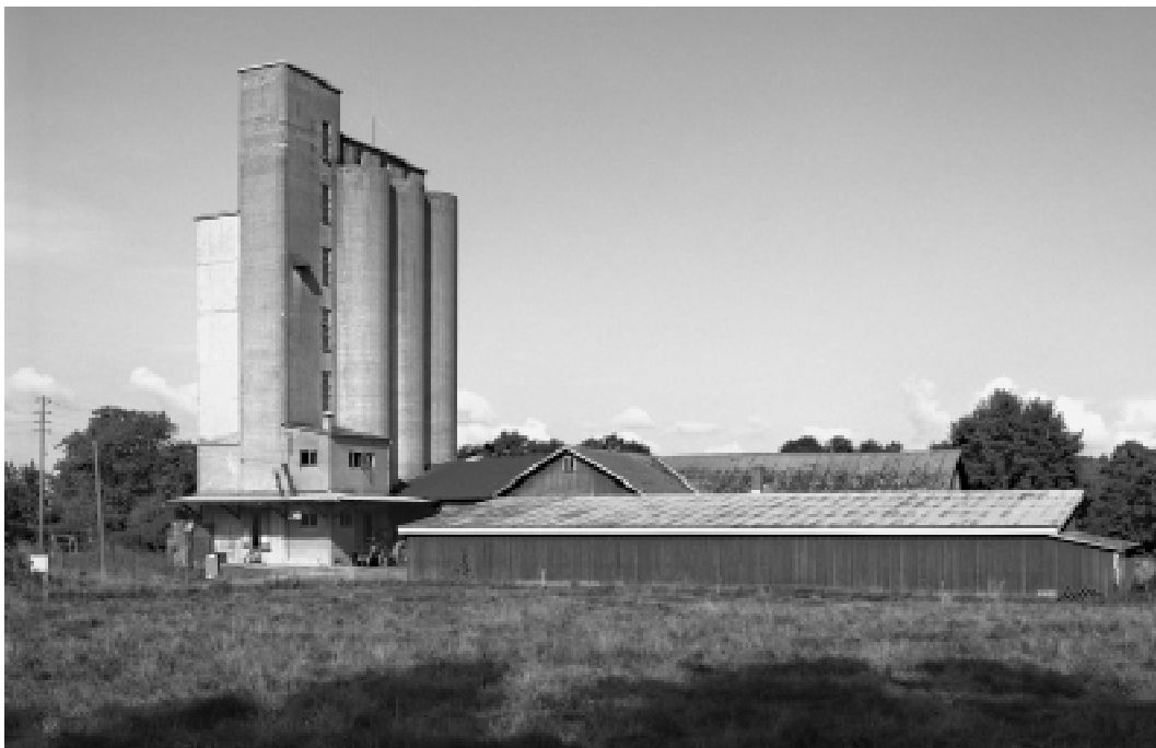
Centralföreningens magasin och den år 1946 uppförda betongsilon i Dalbergså som det såg ut 1991. Anläggningen är numera nedlagd och silon riven. Verksamheten är koncentrerad till Brålanda. Foto: OE, RMVG.
