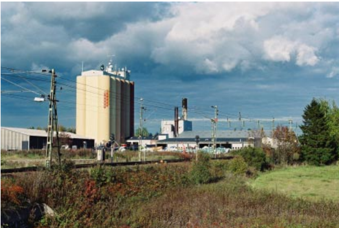
Anläggningen är karaktäristiskt placerad invid järnvägen som tidigare var viktig för transport av såväl inkommande varor som utgående spannmål. Dagens anläggning följer därmed samma mönster som de äldre "Röda och Gula" magasinen. Foto MOW, RMVG.
