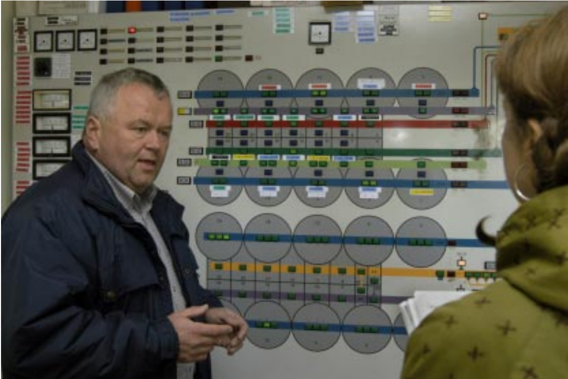
Lantmännens siloansvarige i Brålanda Jens Thomsen förevisar kontrollpanelen varifrån silon styrs. På tavlan syns de 10 runda glidformsgjutna lagringsfickorna (rymmer 1800 ton vardera) samt de 12 mindre, mellanliggande fickorna (rymmer 500 ton vardera). Foto: OE, RMVG.
