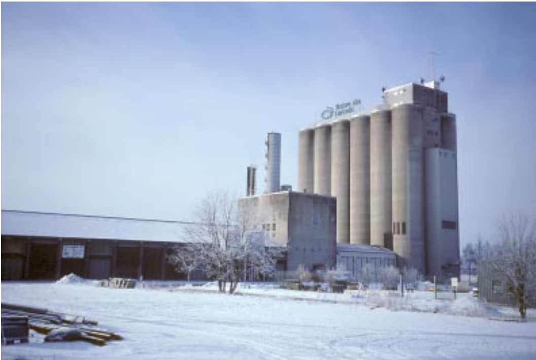
Brålandaanläggningen sedd från nordöst. Bilden är tagen 1996, före impregnering och målning av cylinderbehållarna. Den grå betongen framhäver den geometriska effekten med de cylindriska silobehållarna mot pannrummets och maskintornets lådformer. Foto L. Bergström, RMVG.
