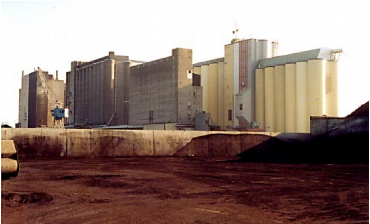
Storleken på Lidköpings terminal är anslående betraktad från NV. Till höger den gulmålade Centralsilon, i mitten Norra silon i fd AB Skaraborgsfoders fabrik, och mot vänster VL:s svin- och hönsfoderfabrik. Bakom hamnkranen ses Östra silon i Västsvenska Kvarns byggnader. Foto i okt. 2005, TCq. Motstående sida: Anläggningen från SV. Foto i okt. 2005, UL.
