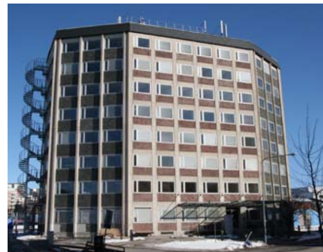
Oktagonen, kulturhistoriskt intressant byggnad enligt ÖP.
