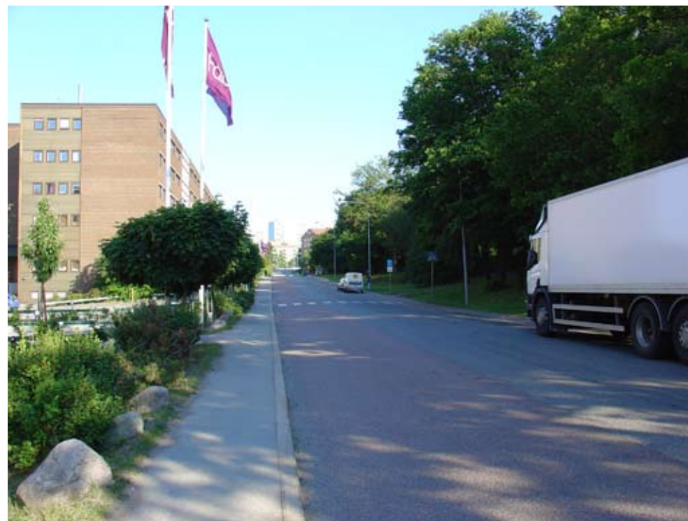
Dalvägen har en geometri som inbjuder till hög hastighet, den byggs för närvarande om.
