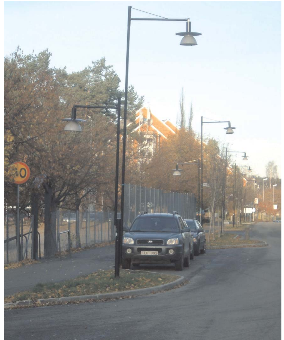
Målade stolpar anger en tredjedel så mycket zink som omålade
