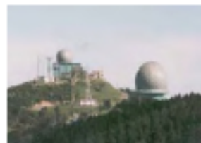
改修予定のFPS-3改
