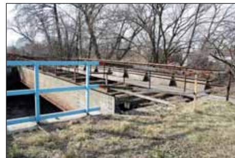
Ocelový most přes Porubku ve Svinově o světlosti 12,0 m byl největším mostním objektem dráhy. Do dnešních dnů plní funkci lávky pro pěší.
