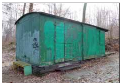
Jediným připomenutím vozidel z éry parního provozu je vozová skříň tohoto služebního vozu s poštovním oddílem řady DF, která slouží jako chata poblíž zastávky linky č. 5 Horní Lhota.
