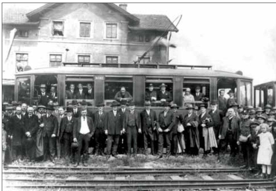
Zahajovací souprava elektrického provozu se slavnostními hosty v Klimkovicích 16. května 1926.
