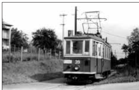
Zastávka Václavovice se nacházela v km 6,940 před křižením s okresní silnicí.
