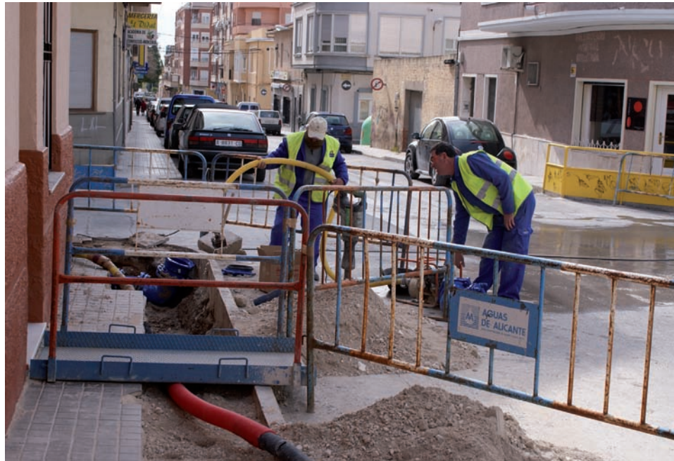
Obras recientes que Aguas de Alicante está realizando en diferentes puntos de la población
