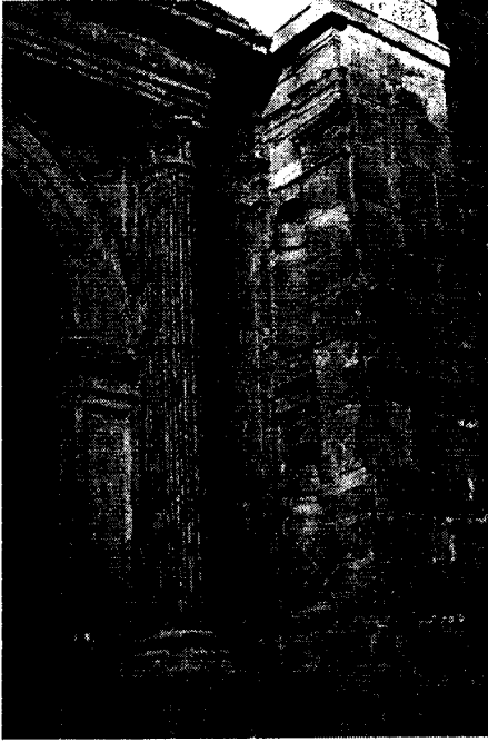
Iglesia de Sacedón - Detalle parcial.
