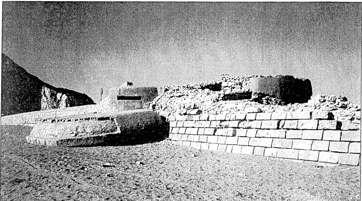
Figura 11. Bunker 163 construido literalmente sobre las murallas de Santa Bárbara.
