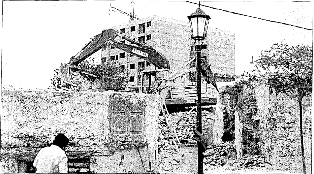
Figura 10. Demolición a finales de los noventa del bunker artillero 151 situado sobre el antiguo baluarte de San Felipe.
