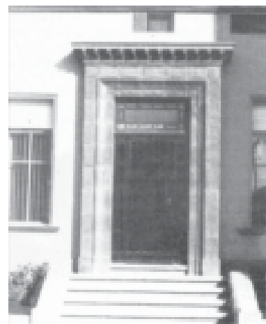
Porta d'entrada a les oficines de can Roca. Hi destaquen les motlures de terracota, típicament noucentistes.
