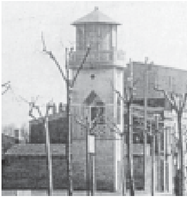
El dipòsit del carrer de Viladecans. Foto: Associació Veïnal del Barri del Centre.
