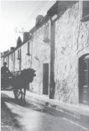
Cases del carrer de Sant Nicasi, edificades al segle XIX. foto: Joan Mitjans.
