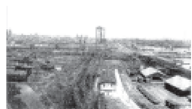
L'estació del port de Barcelona al Morrot, aproximadament on avui hi ha l'edifici de la Duana de Barcelona, va ser la primera estació terme de la línia que passava per Gavà. Al fons de la fotografia es pot veure una bastida metàl·lica: correspon a l'erecció del monument a Cristòfor Colom (1888).
