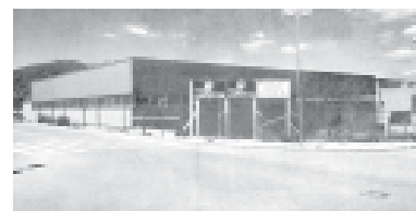
Construcció del pavelló cobert de can Tintorer, que va ser inaugurat el 30 de juny de 1984.
