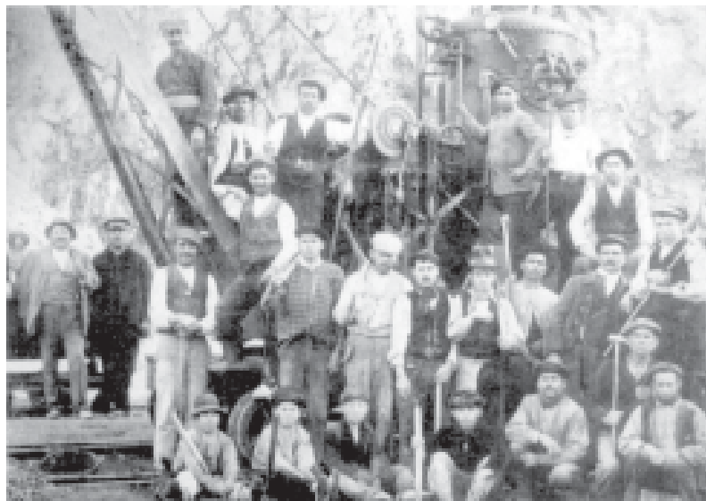
Colla d'obriers treballant en l'estesa de la doble via, al Garraf. Els treballs començaren el 1910 i acabaren el 1914. Foto: col·lecció Manel Alonso.
