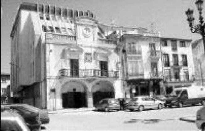
Fachada de los Juzgados de Santoña
