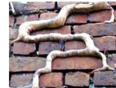
Un érable sycomore a germé dans la maçonnerie, et ses racines ont suivi le contour des briques pour mieux puiser eau et sels minéraux dans les joints © Parcs et jardins, Ville de Lille
