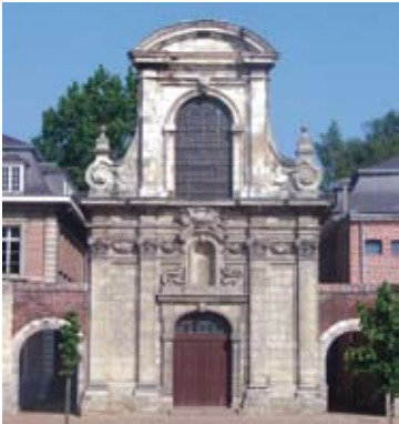
La chapelle introduit à Lille une architecture classique qui servira plus tard de référence : pierres de grand appareil, niche centrale, pilastres corinthiens, fronton courbe, volutes... © Daniel Rapaich, Ville de Lille
