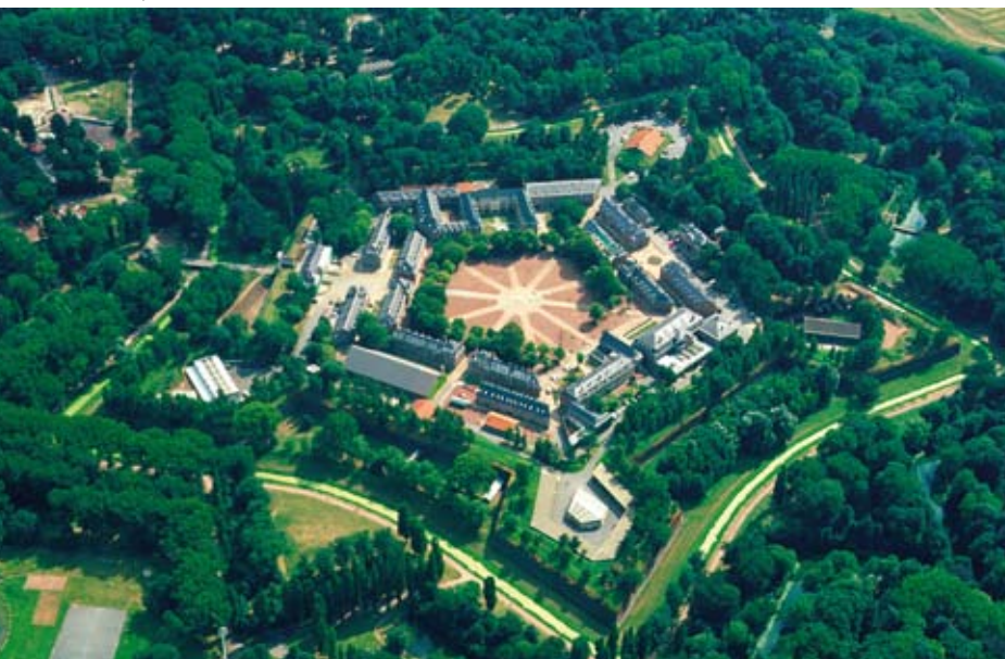
L'étoile à cinq branches de la citadelle se détache encore nettement au cœur du parc boisé © Daniel Rapaich, Ville de Lille
