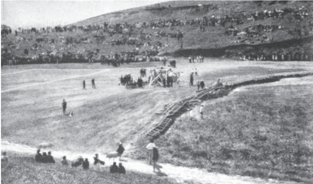
"Una vista del sitio del Stadium que está construyéndose en Jalapa. Éste es el primero que se construye en México, y segundo en América Latina. Tiene capacidad para 30,000 personas, y se logró rellenando un pantano que era un criadero de mosquitos".
