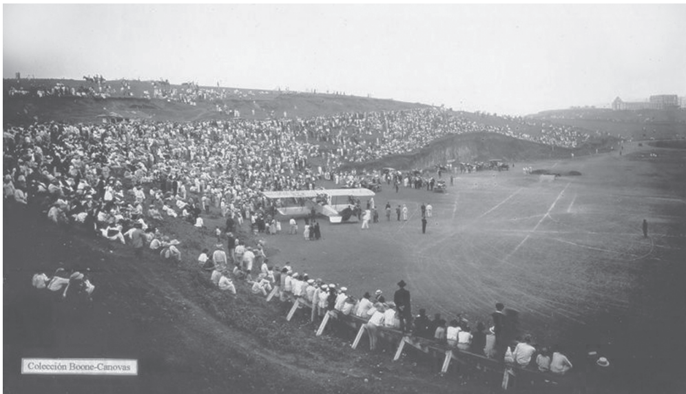
Fotografía tomada el 7 de mayo de 1922 en el evento culminante de las inauguraciones del Camino Jalapa-Veracruz, el Stadium y el Camino Espiral al Macuiltepec. Muestra al piloto acróbata norteamericano, capitán Frank Hawks, acabado de aterrizar en la pista del Stadium , ante el gran asombro de los espectadores. Véase a la derecha, el nuevo hospital que se estaba construyendo y nunca se terminó para ese fin.
