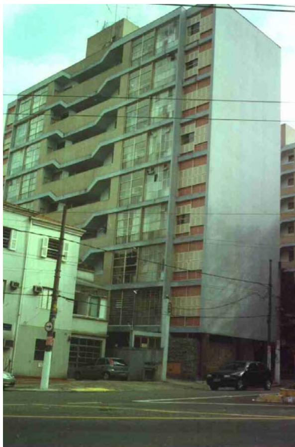
Figura 05 – Fachada de fundos do edifício.
