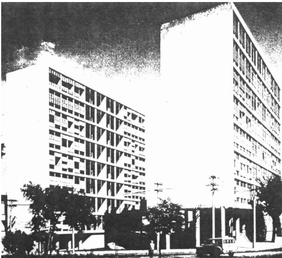
Figura 01 – Fachada frontal do edifício.
