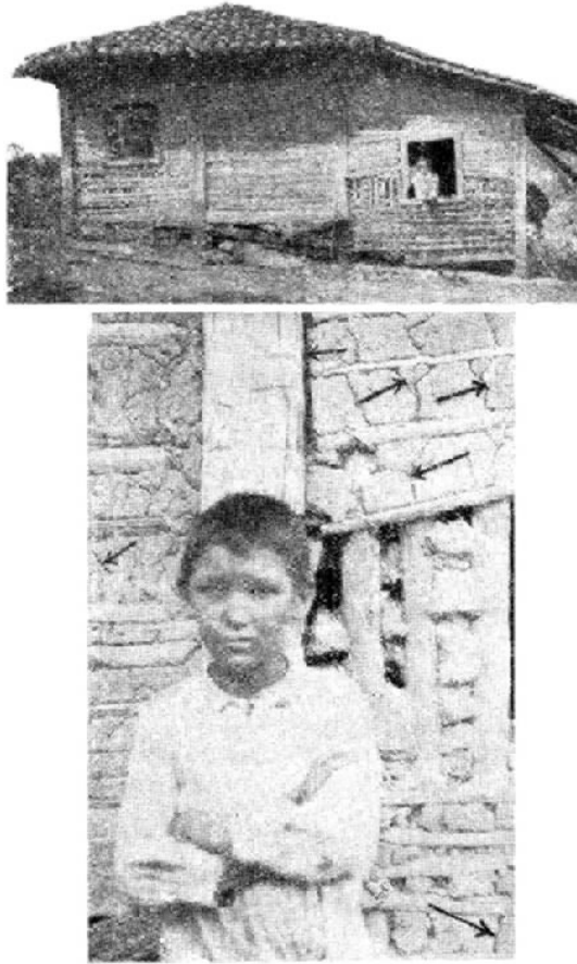
Fig. 366 - Cabana de paredes de barro ordinário, cheias de frestas, onde se desenvolvem os "barbeiros" (De Pinto, 1930, "Arthropodos parasitos", etc., fig. 62).
