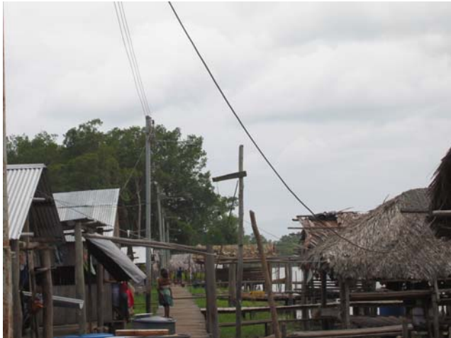
Foto 9. Tendido eléctrico en Morocoto
