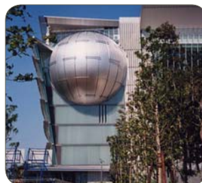
건물 앞면 클래딩 (BUILDING FAÇADE CLADDING)
