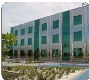
건물 앞면 클래딩 (BUILDING FAÇADE CLADDING)
