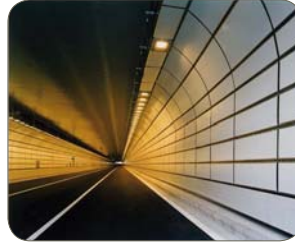
터널 안쪽 벽면 (INNER WALL OF TUNNEL)
