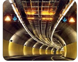
터널 안쪽 벽면 (INNER WALL OF TUNNEL)
