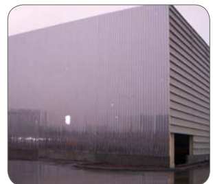
건물 앞면 클래딩 (BUILDING FAÇADE CLADDING)
