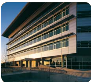
건물 앞면 클래딩 (BUILDING FAÇADE CLADDING)
