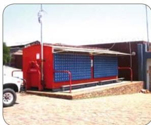
EN 1.4003/410, 페인트 코팅, SASSDA, 남아프리카공화국. 오스테나이트강이 중요하게 검토되던 곳에 "Utility" 400 계를 페인트 코팅 하여 사용하였다.
