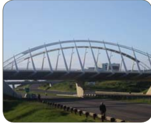
교각의 철강 구조물 (STRUCTURAL STEELWORK OF BRIDGE)
