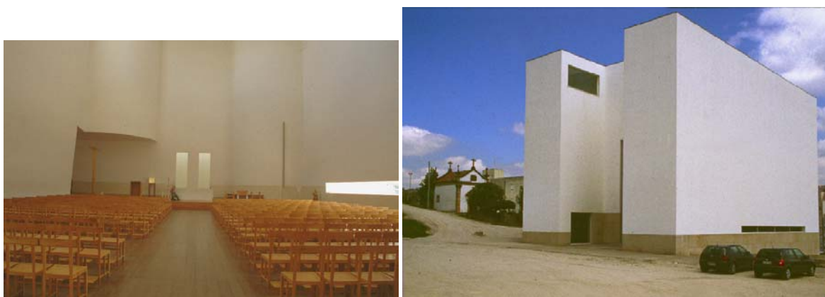
Fig. 95. Igreja de Marco de Canaveses, de Siza Vieira, de 1995.
