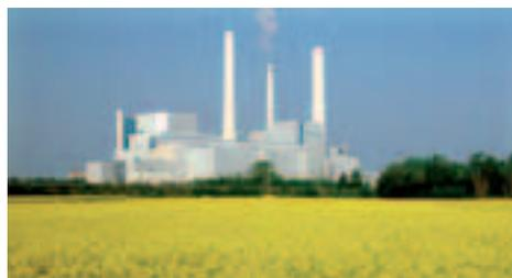
zur Strom- und Fernwärmeerzeugung genutzt. Der jahresdurchschnittliche Primärausnutzungsgrad beträgt mehr als 63 Prozent (übliche Kraftwerke erreichen lediglich circa 35 Prozent).
