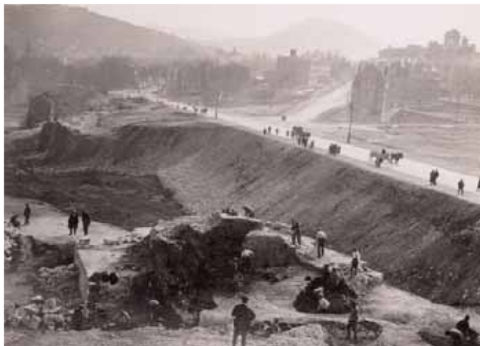
Démolition du bastion de Charmont, 1933 (© Bibliothèques de Besançon, clichés commandant Four)
