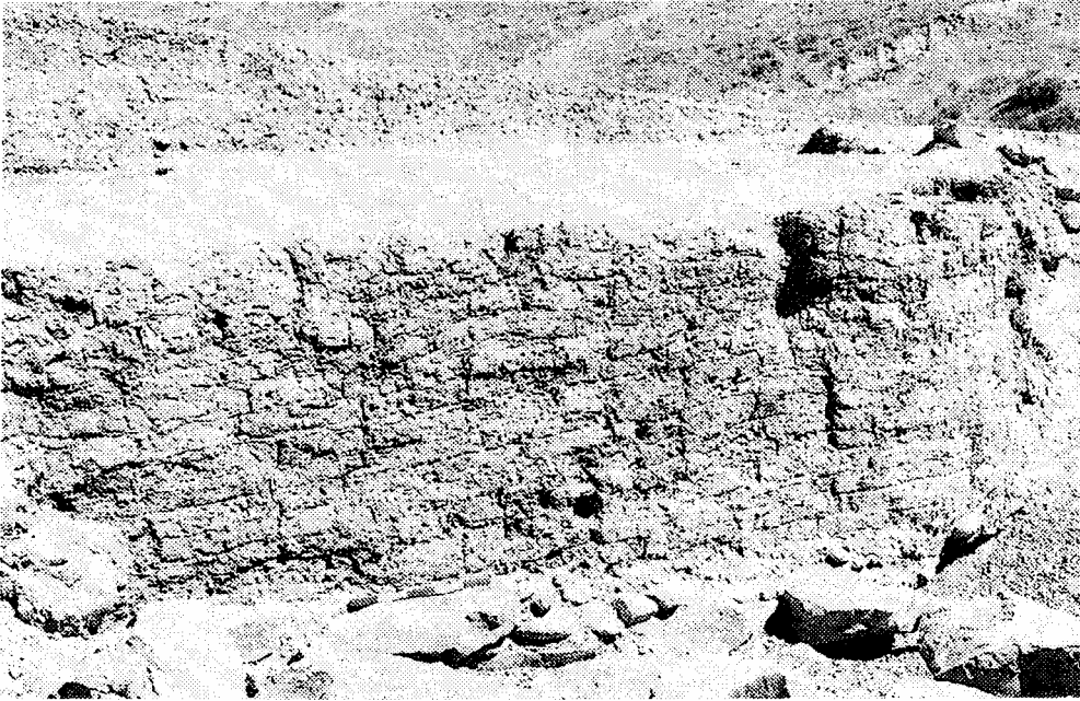
Resim 2. Güneybatı Kerpiç Teras Profili.
