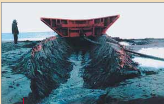
Мощный стальной плуг пропахал подводное «ложе» для трубопровода.
