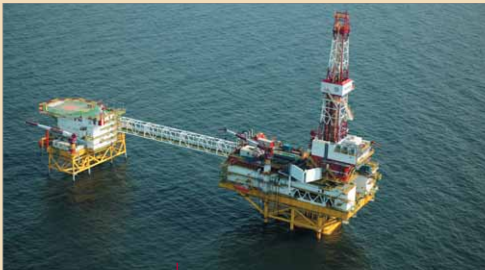
Нефтедобывающая платформа Д-6 – главный форпост ЛУКОЙЛа в Балтийском море.
