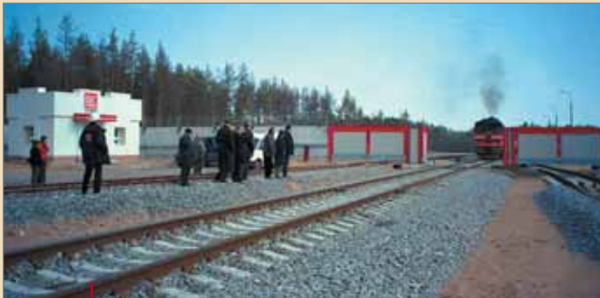
Часть «дуги Баркова» – железнодорожной ветки, связавшей нефтяной терминал РПК «ЛУКОЙЛ-П» с магистралью Санкт-Петербург – Выборг.
