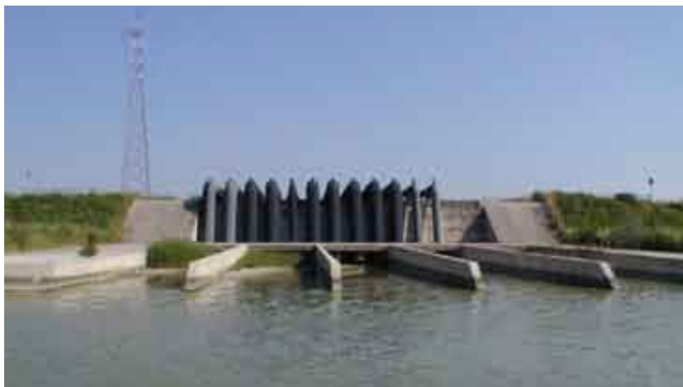
Idrovora per la bonifica della aree dell'Interporto
