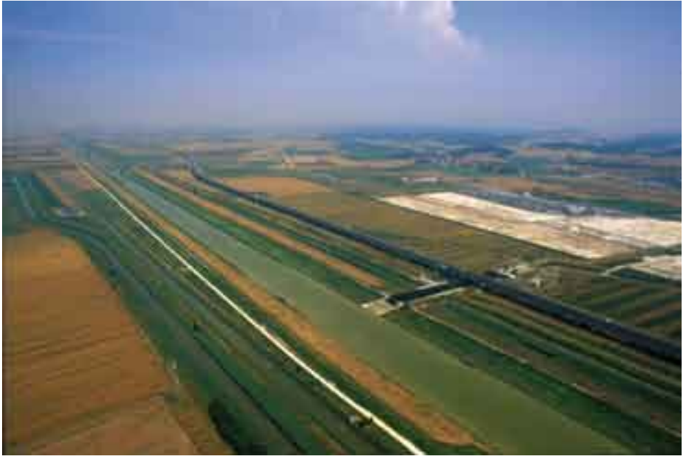
Vista aerea del Canale Scolmatore e delle aree dell'interporto
