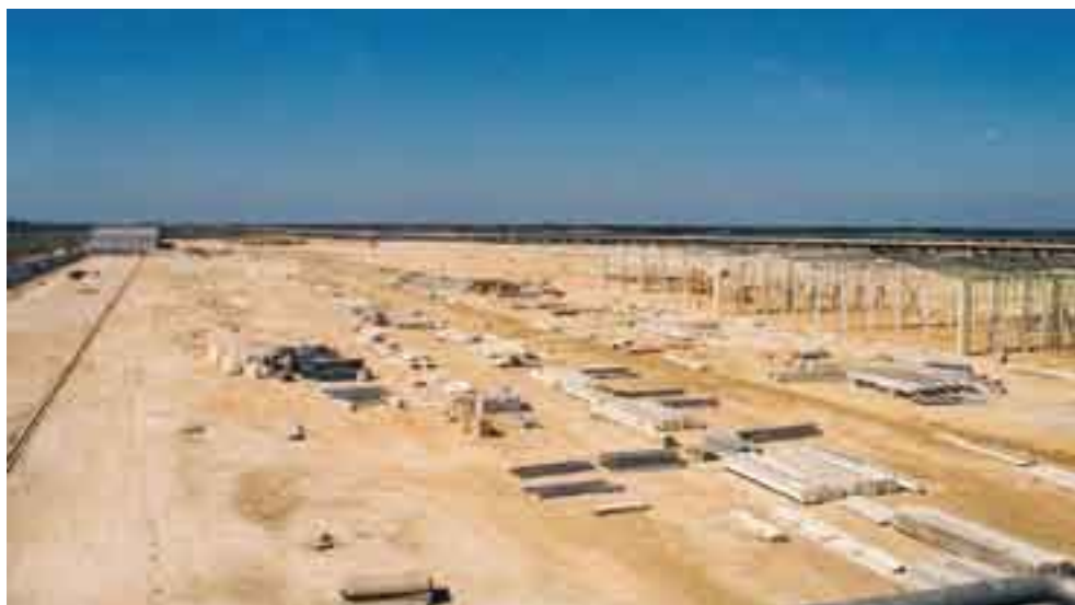
Aree dell'interporto durante la costruzione degli edifici industriali
