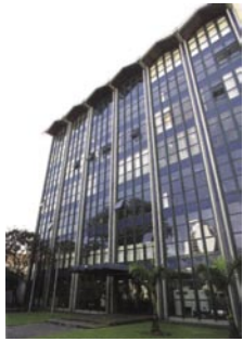
Inauguração da nova sede da Romi-SP, na Rua Coriolano, 710
