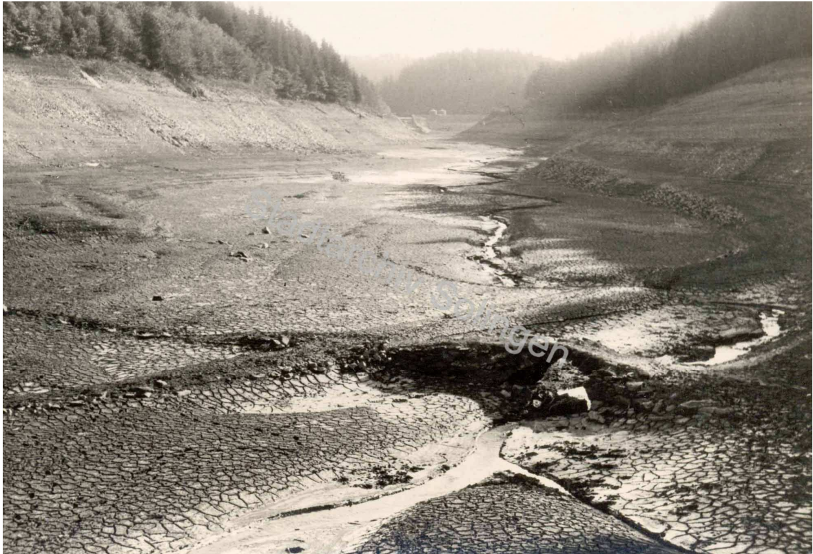
Die anhaltende Trockenperiode hat die Sengbachtalsperre nahezu austrocknen lassen. Jede überflüssige Wasserentnahme ist strikt verboten
