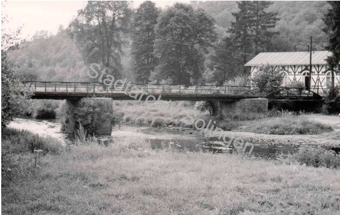
Die in den letzten Kriegstagen zerstörte und wieder errichtete Wupperbrücke bei Glüder
