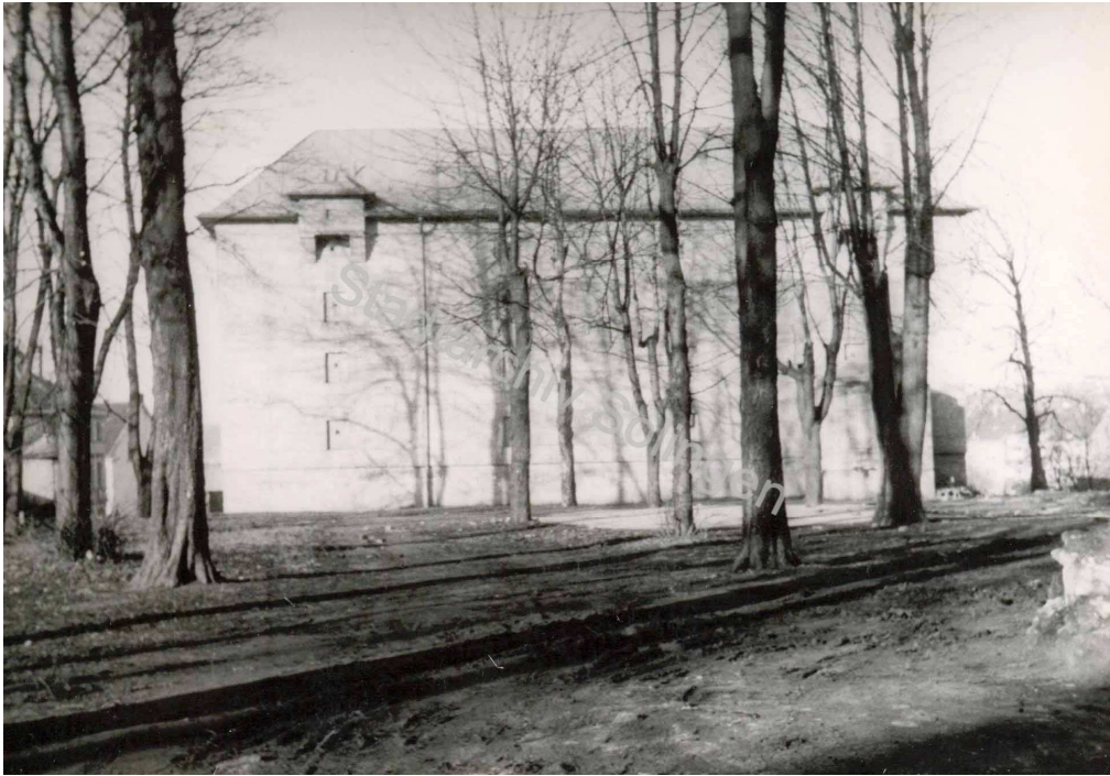
Der ehemalige Luftschutzbunker an der Walter-Dodde-Straße dient bereits im zweiten Jahr als fünfstöckiger "Fürsorge- und Wohnbunker"
