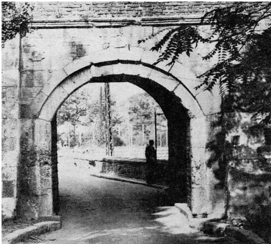
Сл. 10. — Спољна Стамбол капија. Главна фасада. Постојеће стање.
