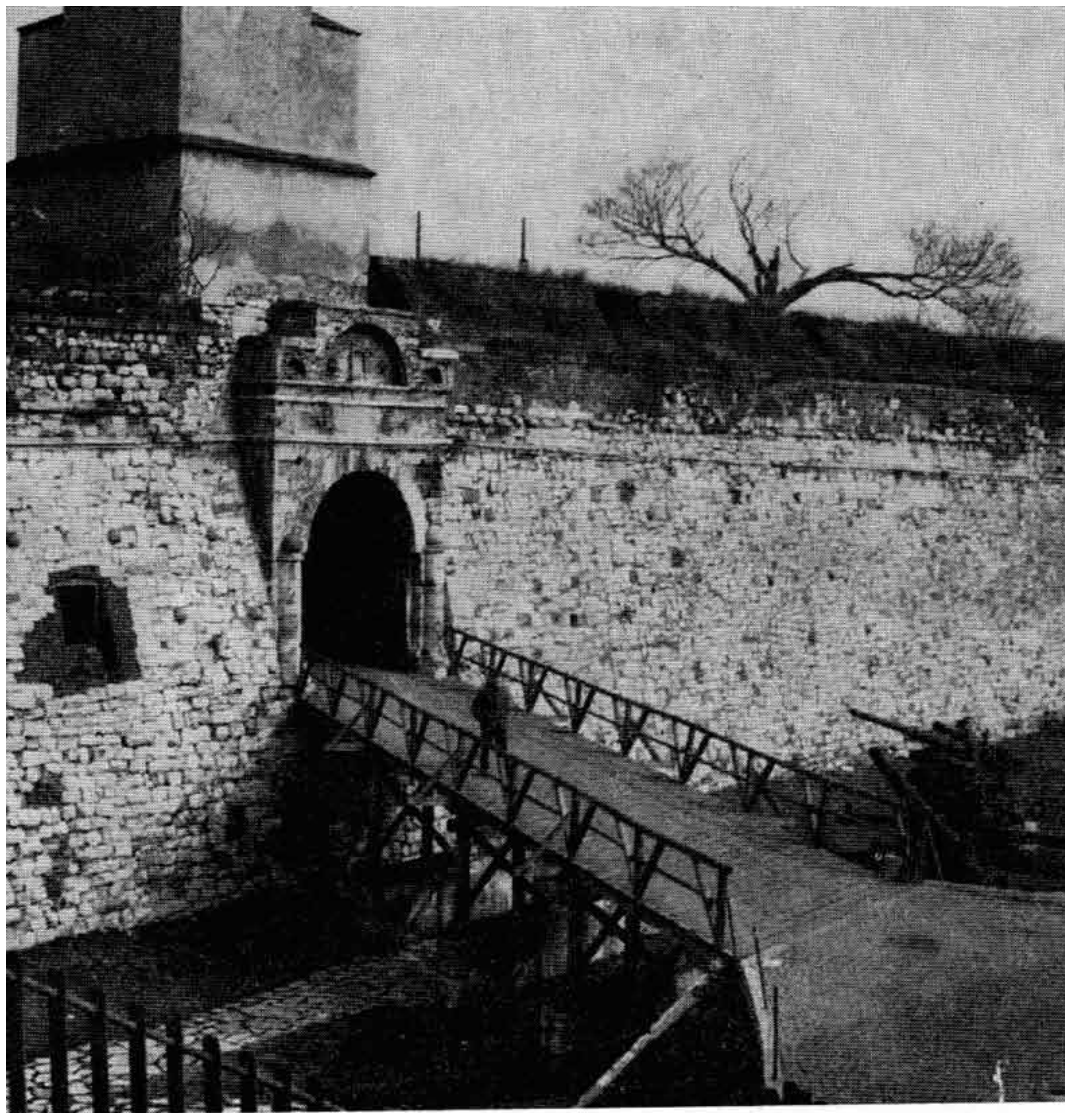
Сл. 23. — Сахат капија. Главна фасада. Постојеће стање. Лево је опеком заидана Капија уз Сахат капију.
