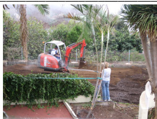
Der Spielplatz entsteht...
