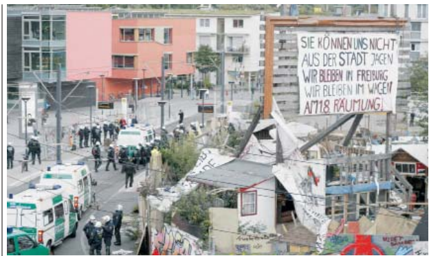
Die Polizei räumt das 1800 Quadratmeter große Baugrundstück der Freiburger Stadtbau GmbH im Vauban-Areal. (Foto: A. J. Schmidt)
