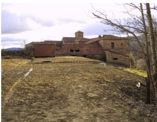
“La Monja” en las proximidades de La Toba de Fuentetoba. En la imagen, explanación realizada para la construcción de un depósito de agua en la actualidad semioculto.
