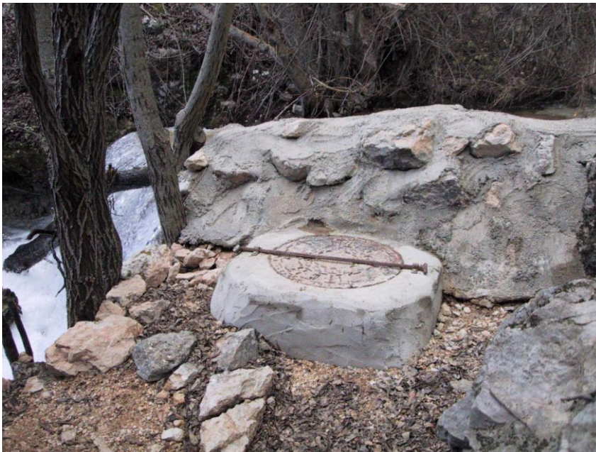
Fig.7. Obras ilegales de captación de aguas, con construcción de un muro y registro dentro del cauce del Río Golmayo, por encima de la cascada de La Toba.
