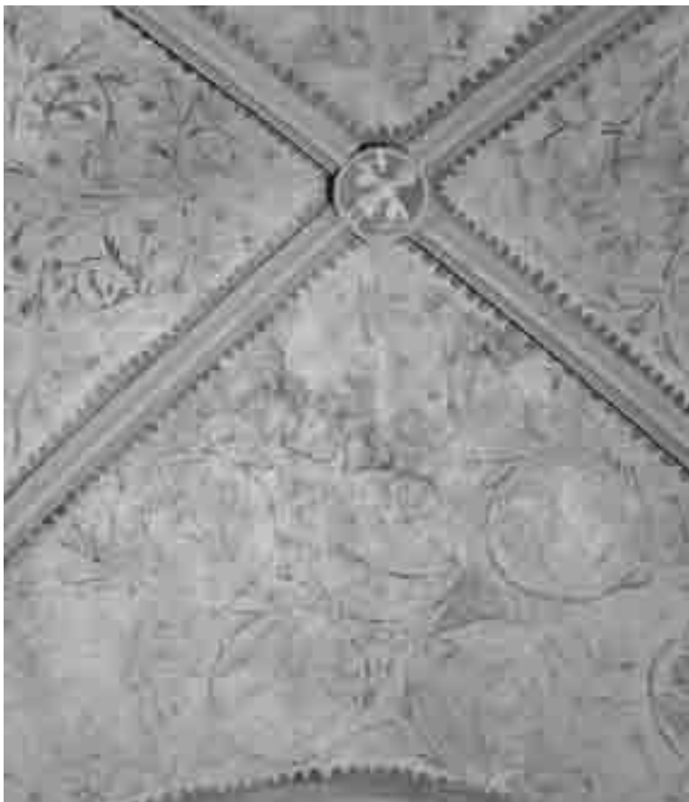
Abb. 39: Auetal-Hattendorf, ev. Kirche St. Eligius, Gewölbe des südlichen Seitenschiff, Ausschnitt. Zustand nach der Restaurierung 1927. Foto 1959.
