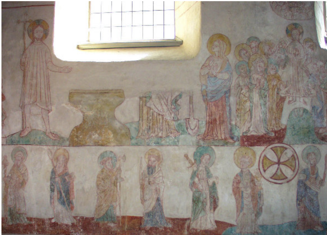
Abb. 52: Wittingen-Ohrdorf, ev. Kirche St. Laurentius, Chorsüdwand mit Fensterverkleinerung aus den 1960er Jahren. Foto 2005
