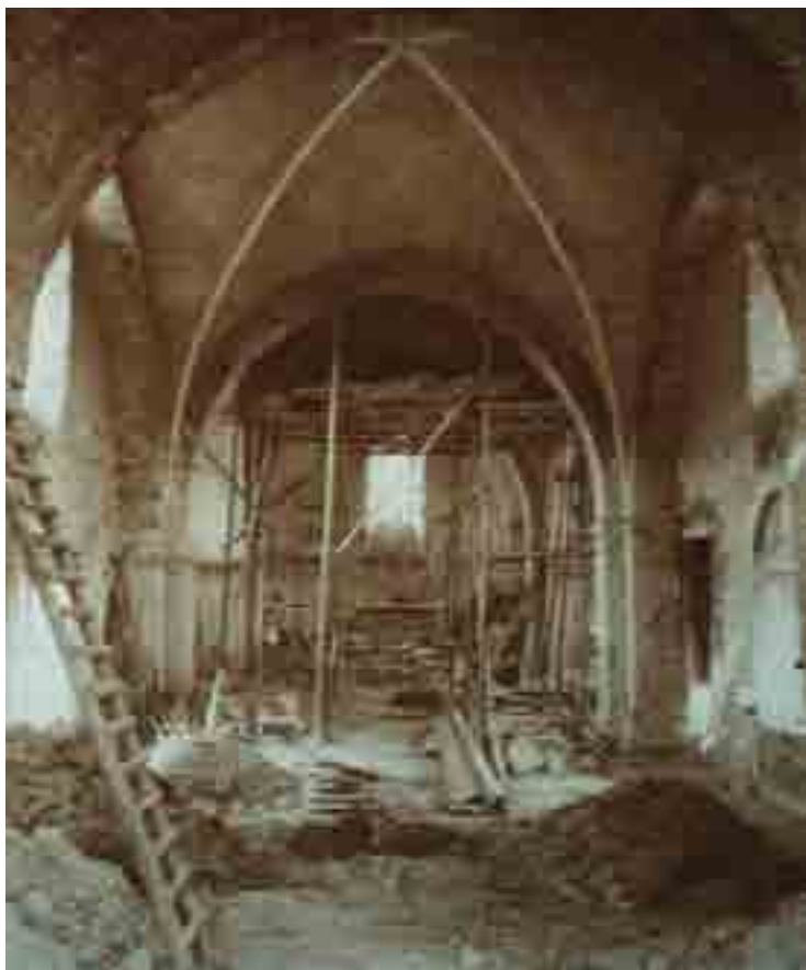
Abb. 28: Bissendorf-Schledehausen, ev. Kirche St. Laurentius, Schiff nach Westen. Zustand während der Renovierung 1903.
