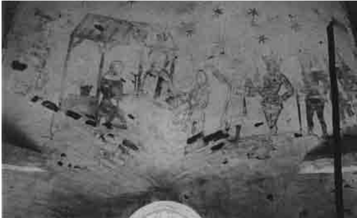
Abb. 5: Loxstedt, ev. Kirche St. Marien, Chor, südliche Gewölbekappe, Zustand nach der Freilegung. Foto 1913.
