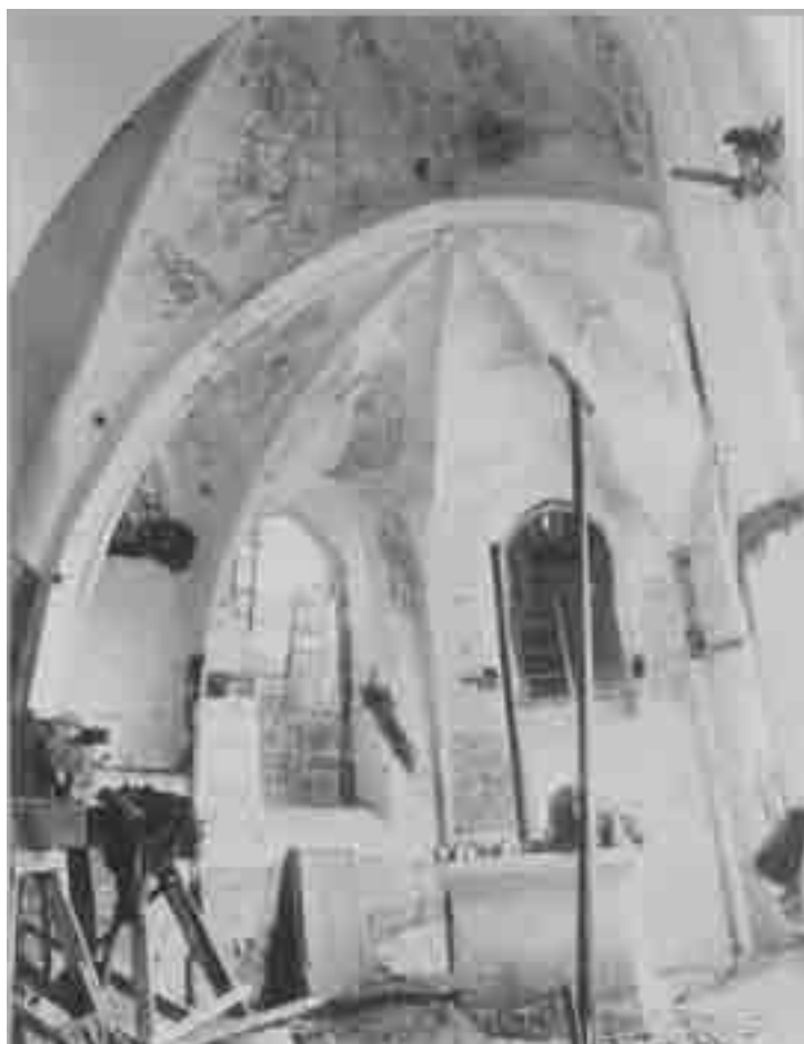
Abb. 3: Isernhagen-Kirchhorst, ev. Kirche St. Nikolai, Chorraum nach der Freilegung 1899.
