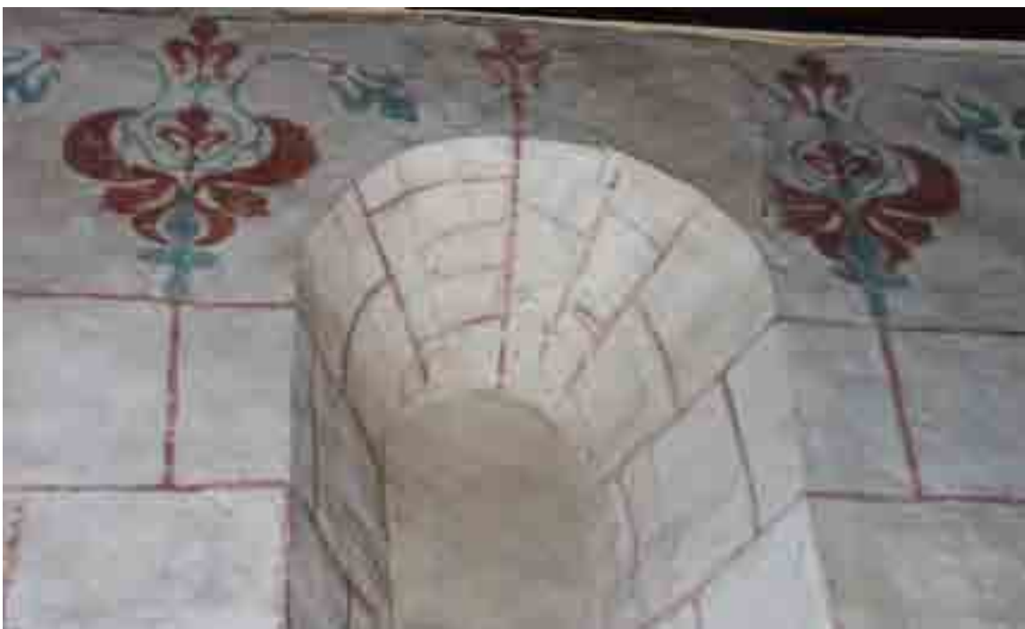
Abb. 59: Wittingen-Ohrdorf, ev. Kirche St. Laurentius, Chornordwand. Quaderung und Ornamentik wurden 1907 übermalt, dabei Abweichung von der ursprünglichen Linienführung. Foto 2005
