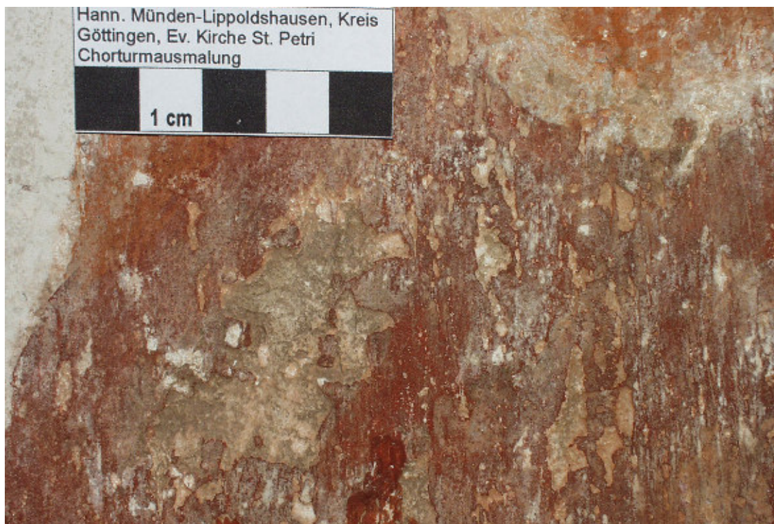
Abb. 76: Hannoversch Münden –Lippoldshausen, ev. Kirche St. Petri, Chorturm, Nordwand. Mittelalterlicher Malereibestand mit grau eingetönten Fehlstellen durch Bucker 1911. Foto 2005.
