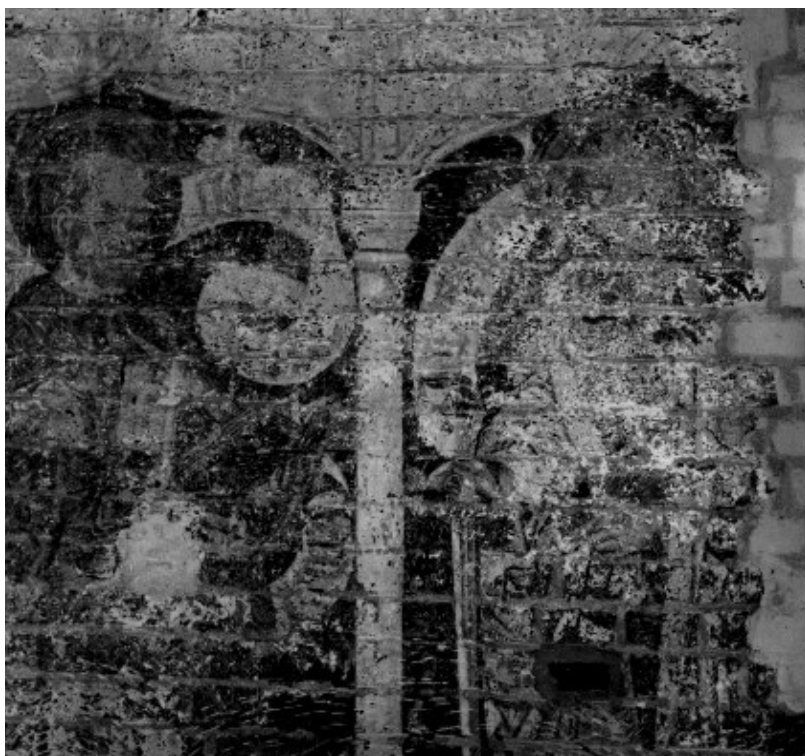
Abb. 8: Neustadt-Mandelsloh, St. Osdacus, Chornordwand, Zustand nach der Freilegung 1907/08.
