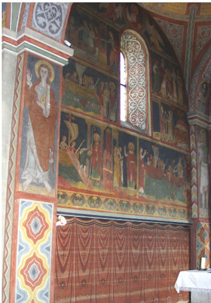
Abb. 19: Braunschweig-Melverode, ev. Kirche St. Nikolai, Chornordwand, Zustand 2005.
