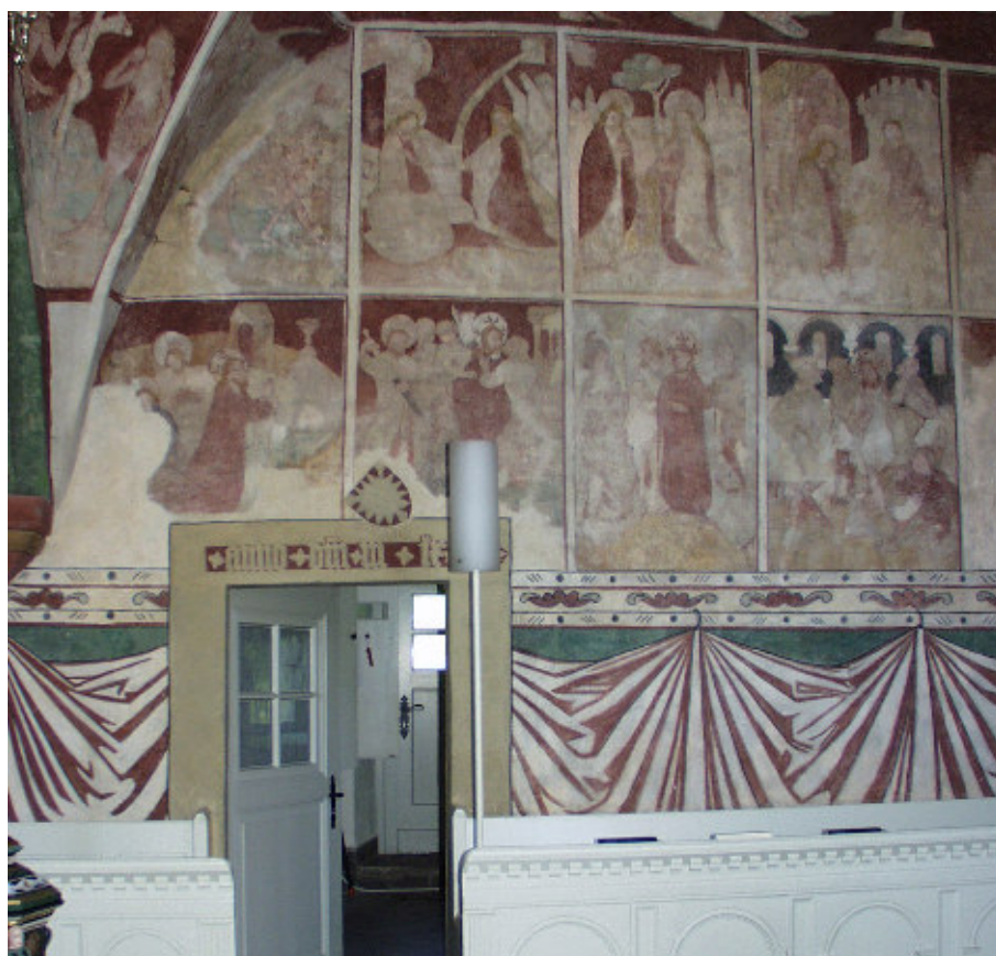
Abb. 63: Hessisch Oldendorf-Großenwieden, ev. Kirche St. Matthäi, Chornordwand. Foto 2005.
