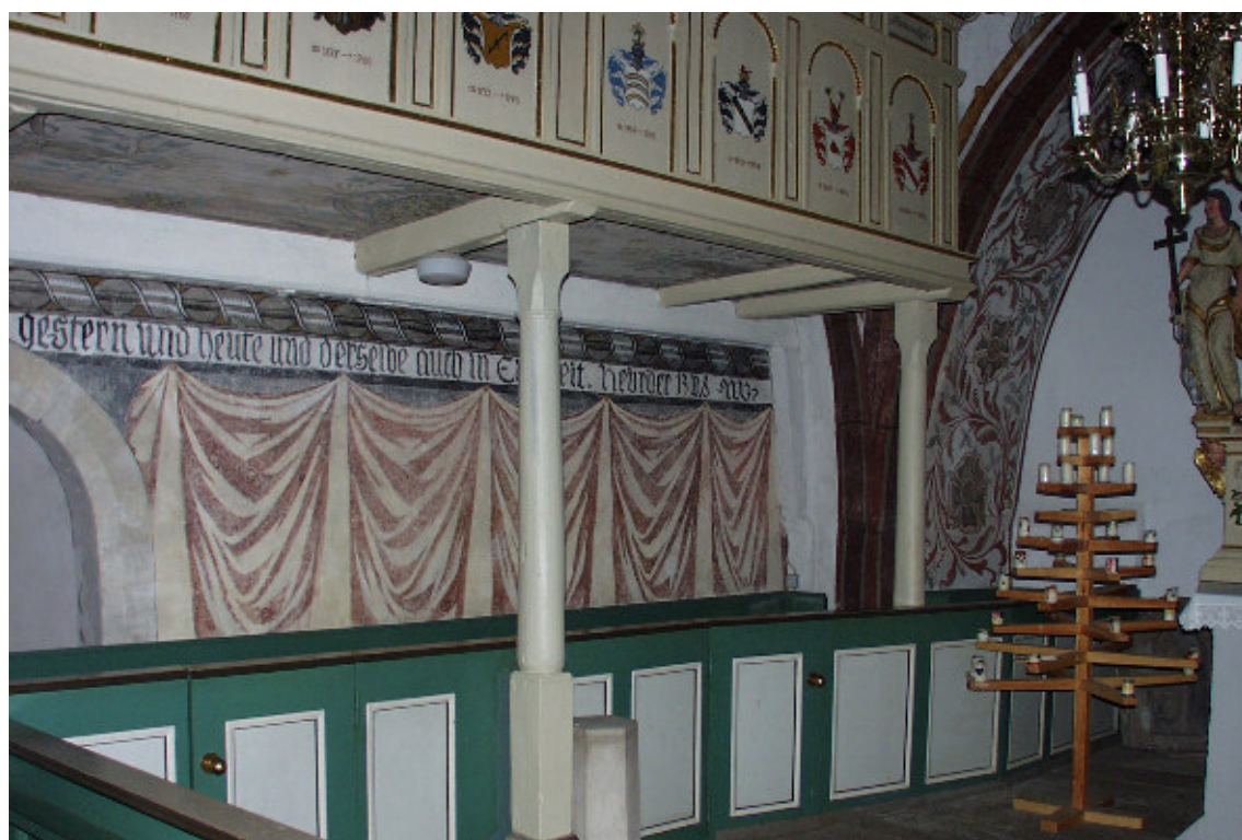
Abb. 61: Gehrden-Leveste, ev. Kirche St. Agatha, Chornordwand. Vorhangdraperie und Ornamentik lasierend übermalt. Foto 2005.
