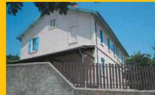
L'école du Cadran, située à deux pas de la mairie, est parfois appelée Ecole de la République par les Romettins.
