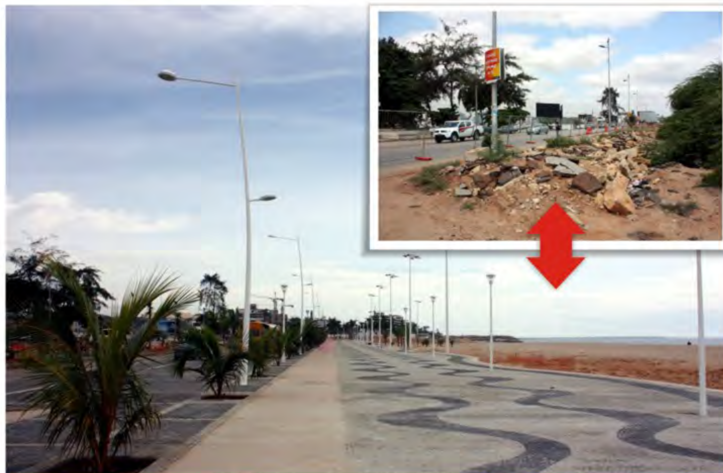
Situação actual do calçada da ilha. No detalhe, troço antes das obras de revitalização.
