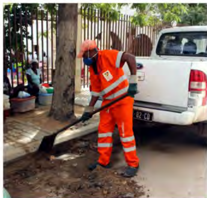
Trabalhador da equipa a desobstruir sumidouro no Largo do Ambiente.
