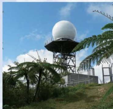
▲石垣島レーダー
