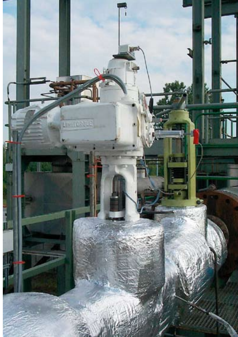
Erprobung einer Frischdampfabschlussarmatur
