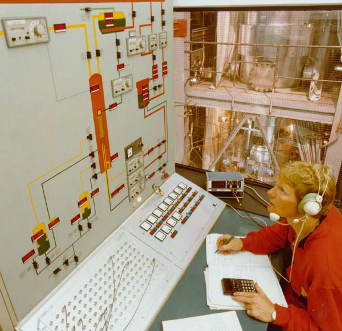
Kontrollzentrale für die Versuchsstände in der großen Technikumshalle
