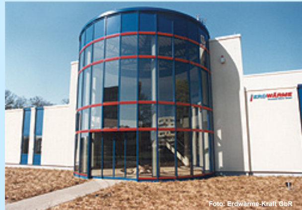
Geothermisches Heizwerk in Neustadt-Glewe
