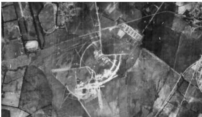
Fotografía del sector de la Ciudad Universitaria, cuando comenzaban las obras. 1935. © IGAC.
