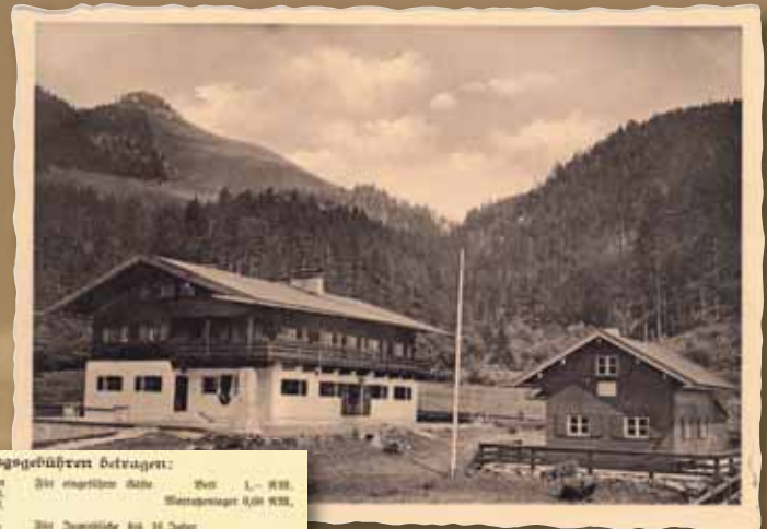
Das Willy-Merkel-Haus nach der Fertigstellung 1938, rechts die kleine Hütte von 1934
