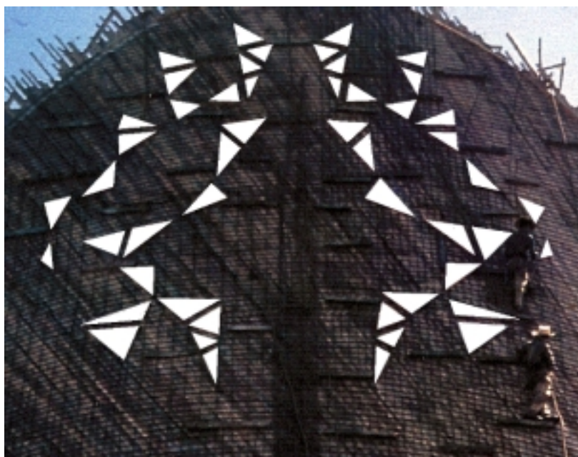
Fig. 8. Calados en la parte superior de la lámina en la ejecución original de la Capilla abierta en las Lomas de Cuernavaca, Morelos, 1958-59. Arquitectos: Guillermo Rosell y Manuel Larrosa (fotomontaje del autor).
