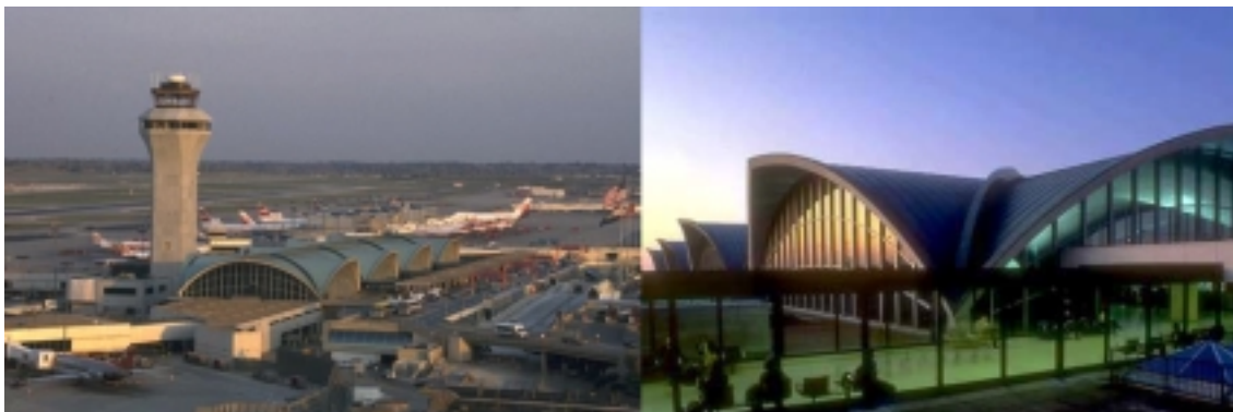
Fig. 6. Terminal Lambert del aeropuerto de Saint Louis, 1955. Arquitecto: Minoru Yamasaki. Ingeniero: Anton Tedesko.
