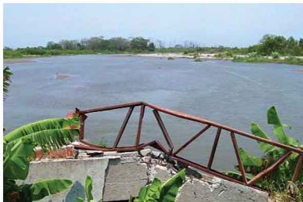
Rancho Grande, destrucción y terrenos perdidos, antes en México hoy en Guatemala.
