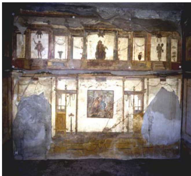
Pitture murali interne in evidente stato di degrado e soggette ad errati interventi precedenti
