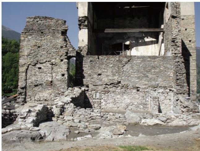
4. Veduta generale da est in corso di scavo. (S.E. Zanelli)
