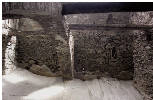
8. Alla base della struttura sullo sfondo le fondamenta del precedente edificio. (S.E. Zanelli)
