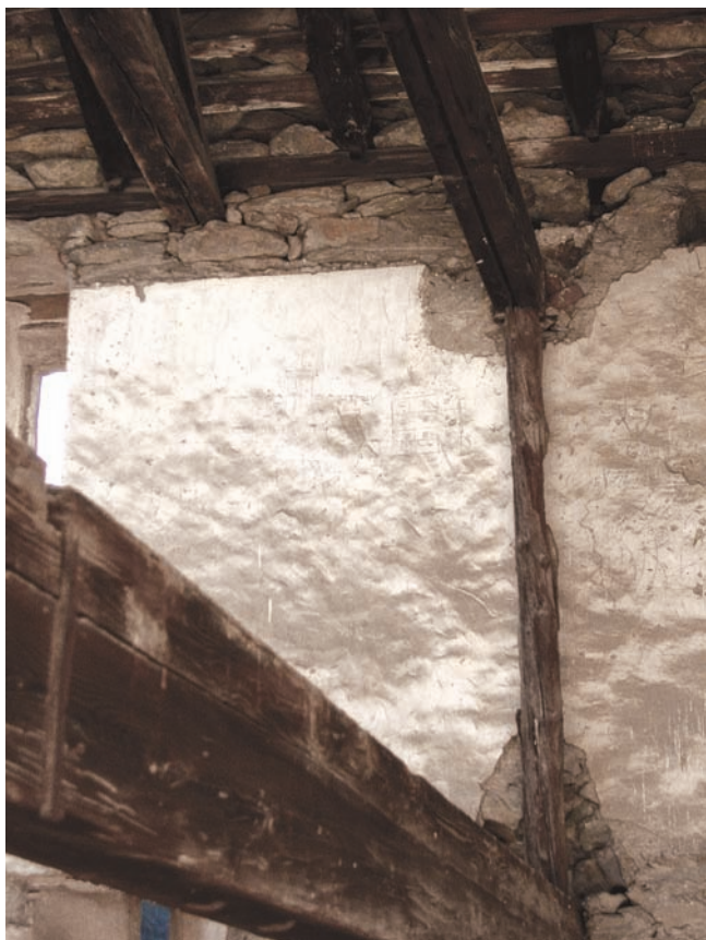
10. Particolare di una tramezzatura lignea, di cui rimangono travi e montanti, al piano del camino. (S.E. Zanelli)
