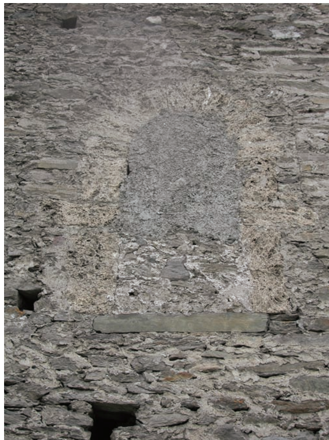
13. Porta inserita in rottura poi tamponata; in alto a destra si scorge la traccia di una precedente finestra. (S.E. Zanelli)
