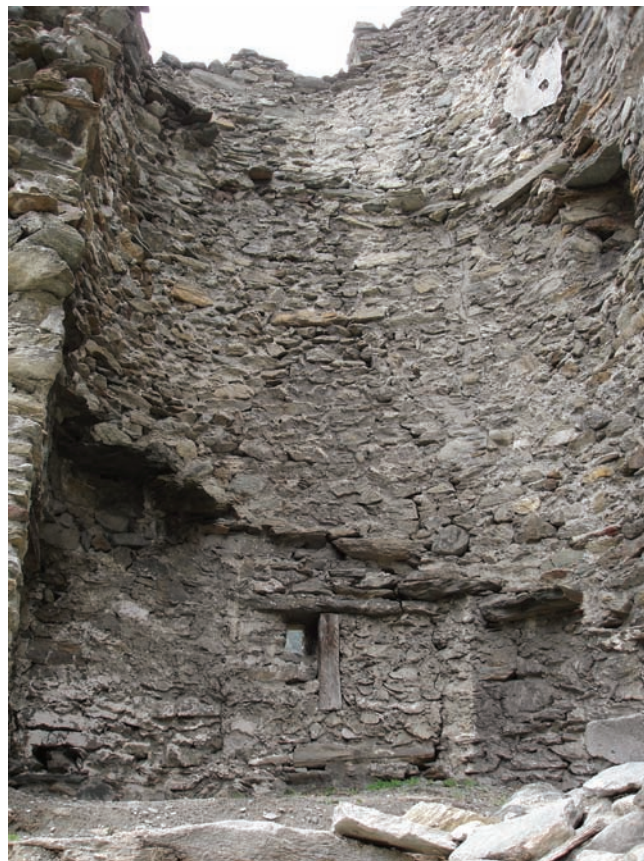
18. Tracce della scala elicoidale. (S.E. Zanelli)
