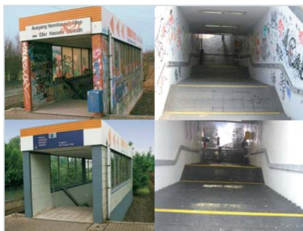
S-Bahn-Haltepunkt Düsseldorf-Eller: vorher - nachher Fotos: DB Services GmbH
