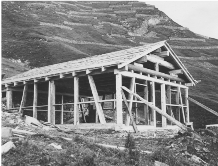
1957 Neubau «Hoor»-Unterkunftshütte, Riegelbau. Im Hintergrund Verbauungen, Trockenmauern «Hooraeegt».
