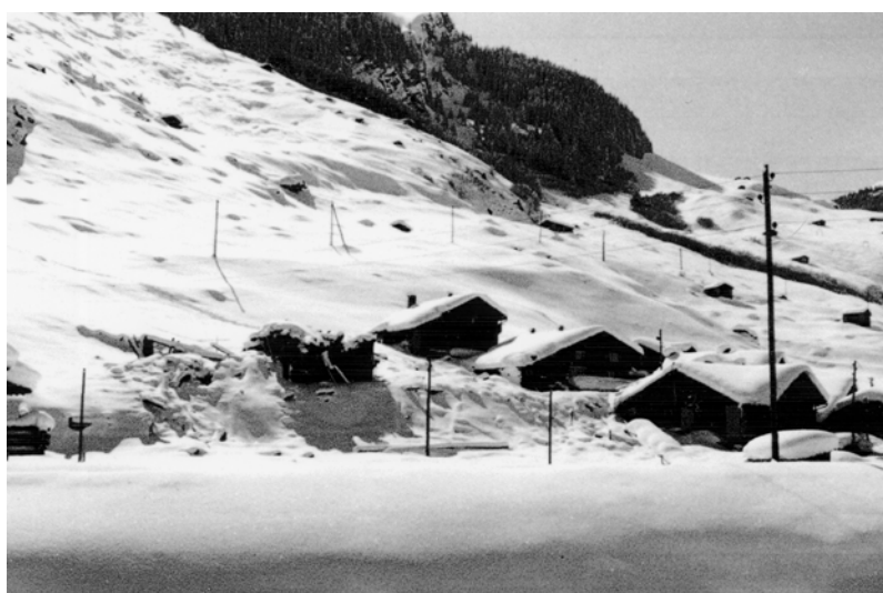
Links das zerstörte Haus in «Oberzameia»
