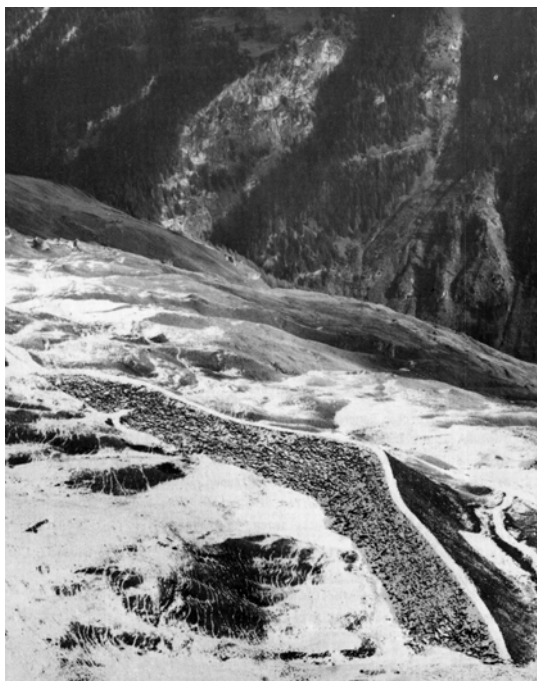
Lawinenauffangdamm auf der Alp Leis
