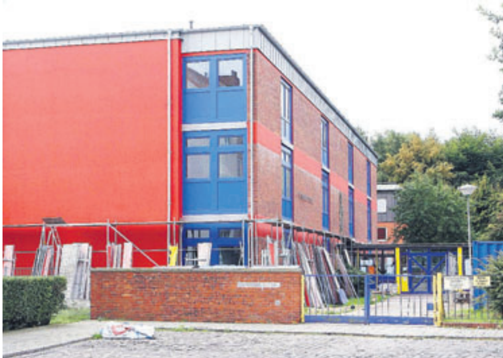
Der 50 Jahre alte Neubau der St.-Marien-Schule wird gerade renoviert. FOTO: WALTER GERBRACHT
