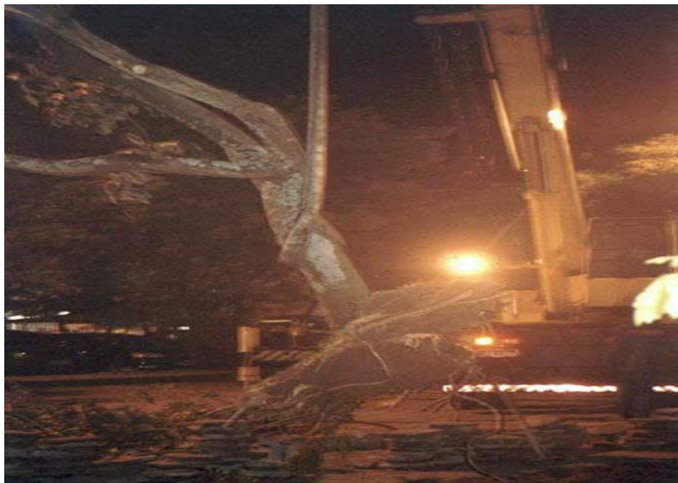
Figura 3 - Retirada da vegetação do parque ilegalmente com escavadeiras e tratores, em 29 /05/2006, Fonte: www.vitruvus.com.br/ minha cidade- em 23/10/2008
