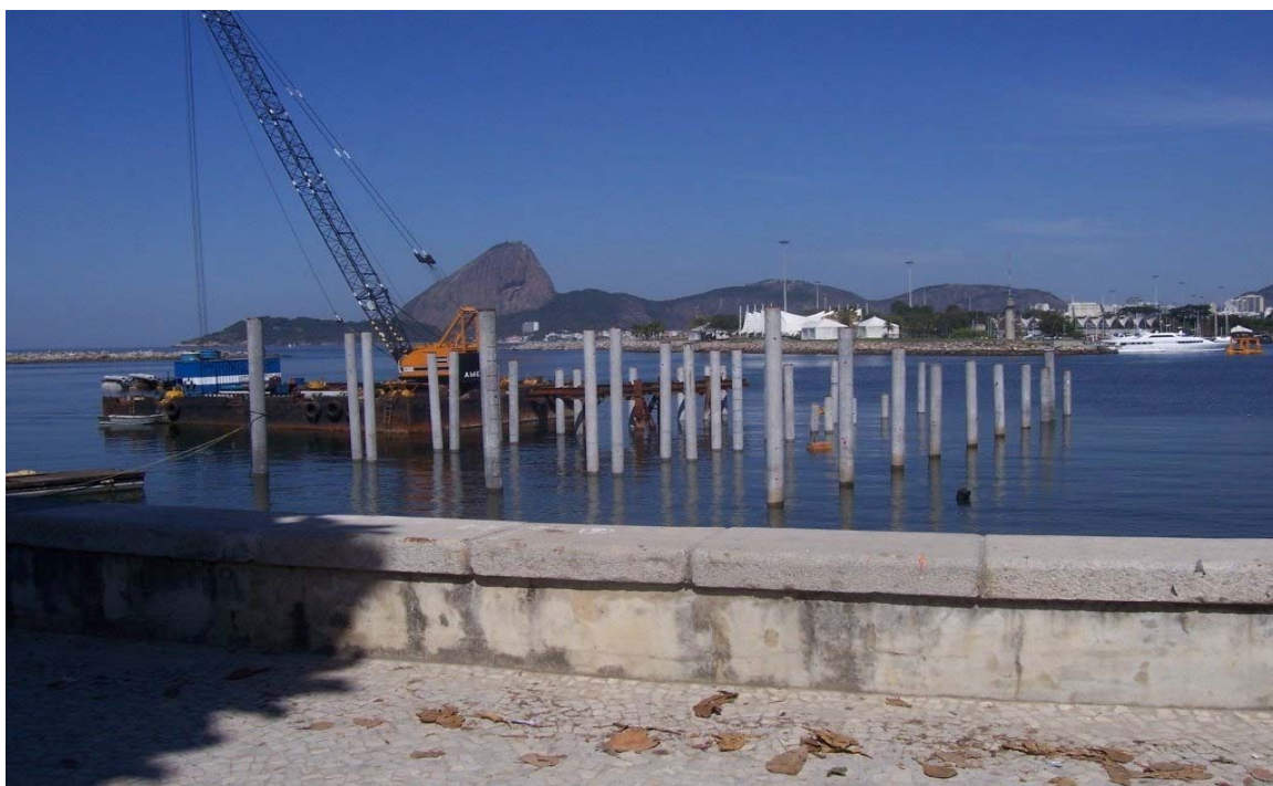
Figura 6 - Bate-estacas abandonadas na enseada da glória pela EBTE, resultado da ilegalidade da obra embargada pelo IPHAN. Fonte: Arquivo pessoal de Joyce Domingues, novembro de 2006, integrante do movimento S.O.S Parque do Flamengo, da associação de moradores da Glória e do Comitê Social do Pan.
