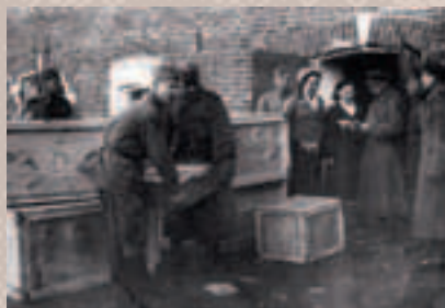
12 октября 1941 года по приказу Государственного Комитета Обороны на Каширской ГРЭС начался демонтаж оборудования, а уже 14 октября в Новосибирск пошли первые эшелоны с котлами и турбинами. За два месяца было отправлено около 500 вагонов.
