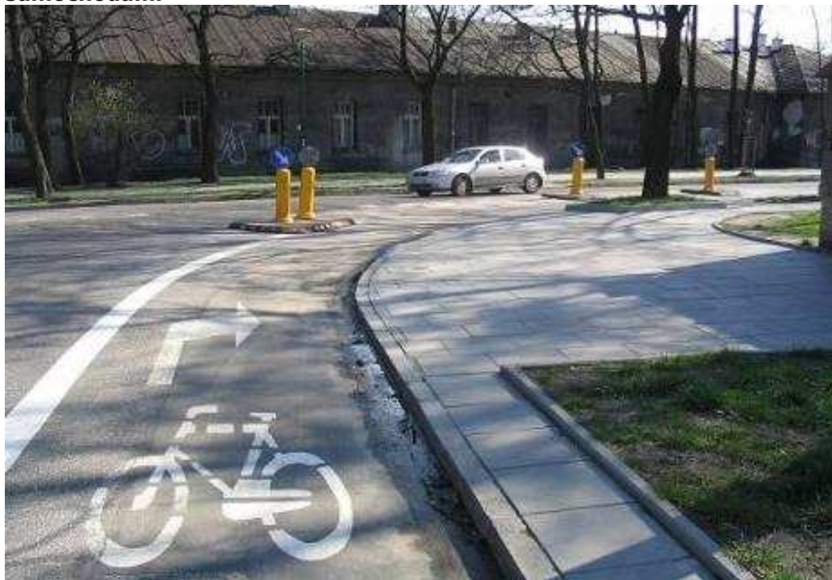
Rys. 5. Kontrapas rowerowy w rejonie łuku poziomego – wysepki dzielące zabezpieczające rowerzystów przed ścinającymi zakręt samochodami
