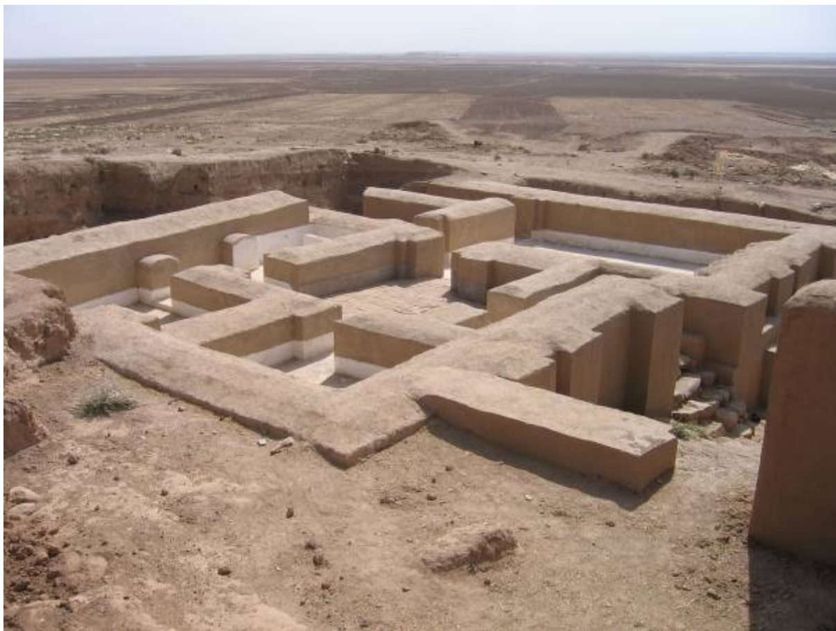
Restauration du Temple D
