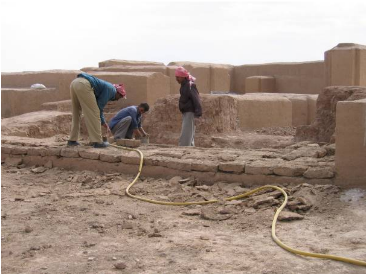
Travaux de restauration en cours dans le Palais.
